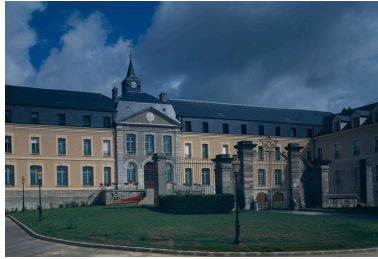
La grille d'entrée. Phot. Thierry Lefébure IVR22_19940200814XA
