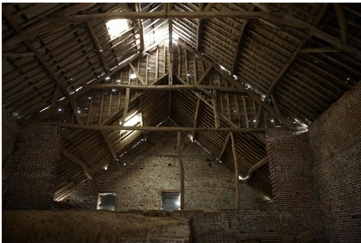
Vue intérieure de la grange.
