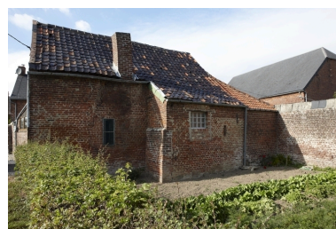
Vue du revers du four à pain (?). Phot. Pierre Thibaut IVR31_20095903225NUCA
