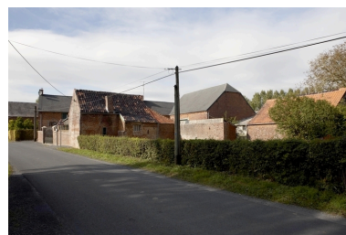
Vue générale. Phot. Pierre Thibaut IVR31_20095903232NUCA
