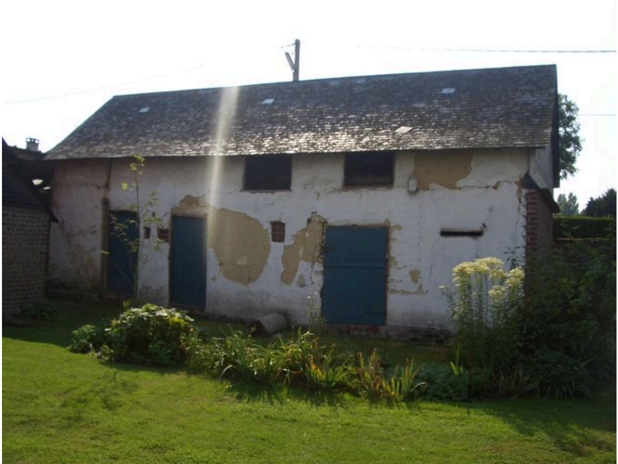
Vue des écuries longeant la rue.
