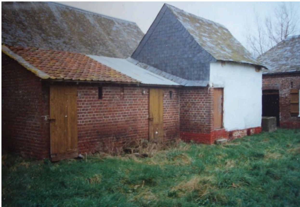
Vue des étables à cochons aujourd'hui disparues pour une partie et en cours de restauration pour le reste du bâtiment.
