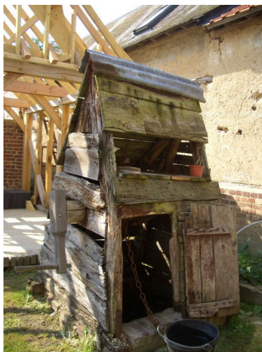
Vue du puits à manivelle situé devant le logis.
