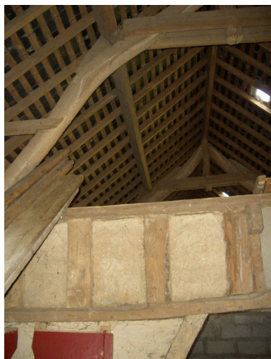
Vue détaillée d'une partie du système de cloison intérieure.
