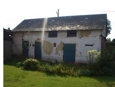
Vue des écuries longeant la rue.
