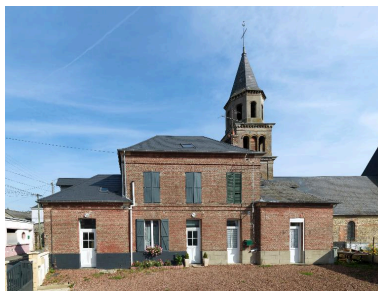
Vue générale. Phot. Thierry Lefébure IVR22_20148000510NUC2AQ
