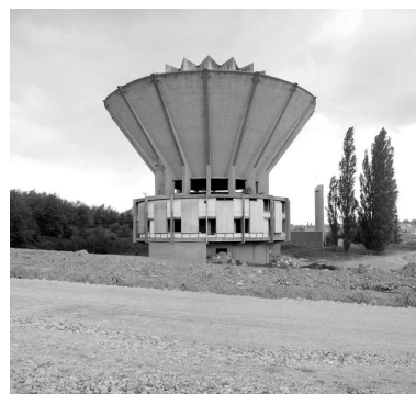
Le répartiteur ou Dispatching, vers l'ouest. Phot. Thierry Petitberghien IVR31_20025902063X
