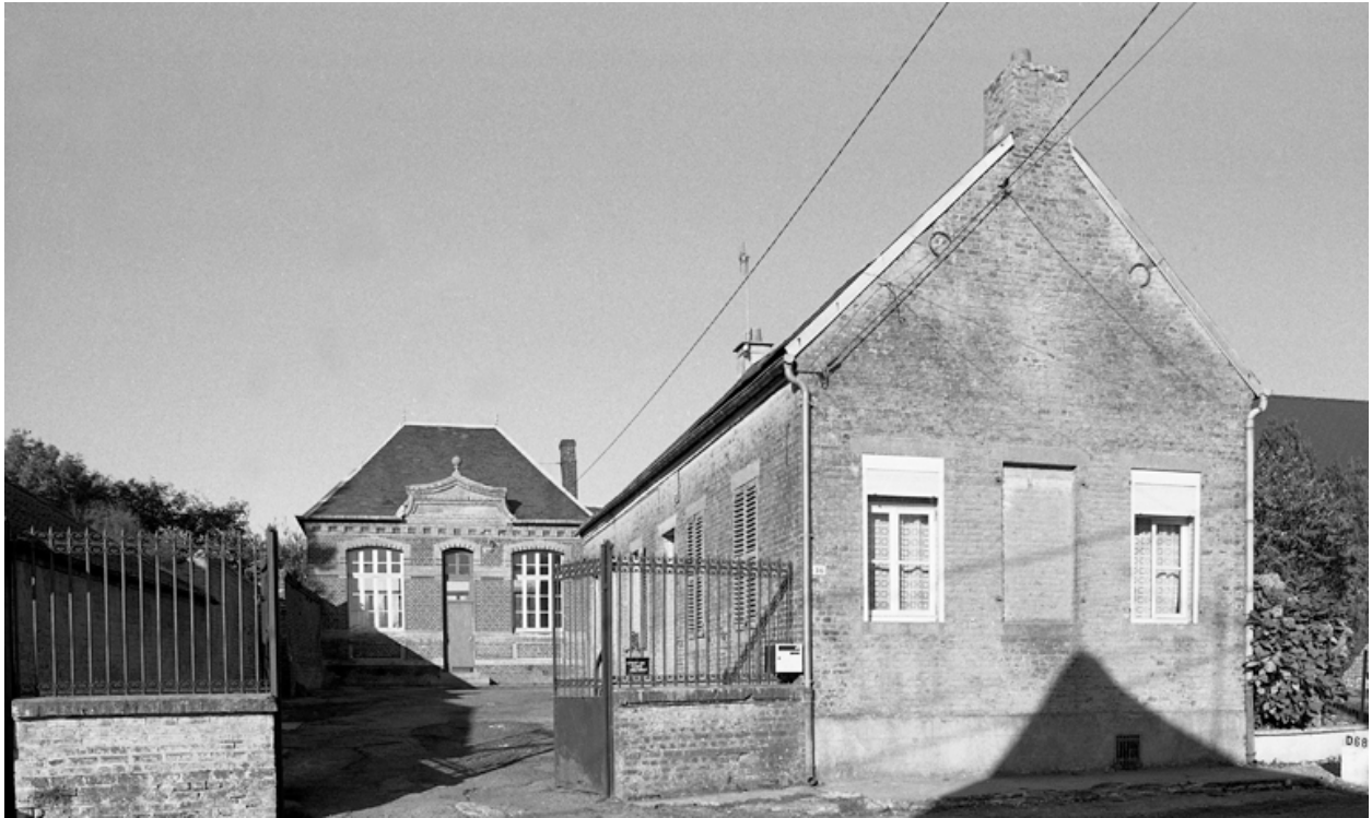
Vue d'ensemble sud-est.
