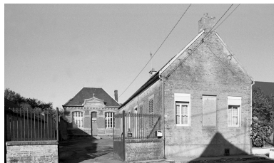
Vue d'ensemble sud-est. Phot. Christiane Riboulleau IVR22_19940201486Z
