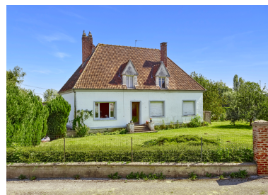
Vue de la maison depuis le nord-ouest. Phot. Thierry Lefébure IVR32_20248001140NUCA
