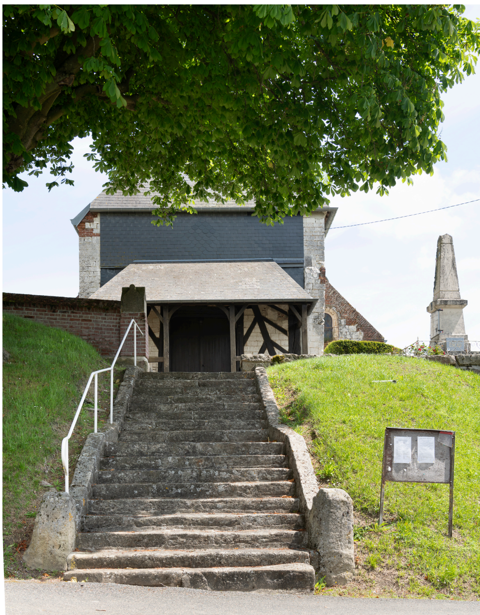
Accès à l'entrée occidentale de l'église.
