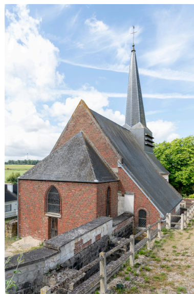
Vue du chœur depuis le cimetière en surplomb. Phot. Marc Kérignard IVR32_20246000666NUCA
