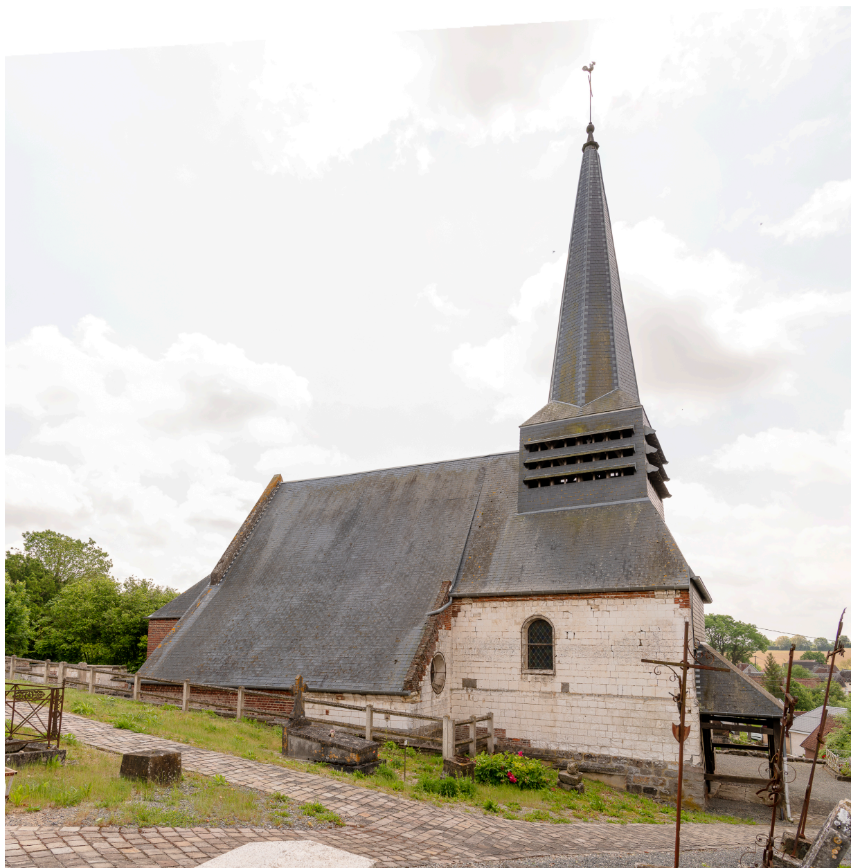
Élévation nord de l'église.
