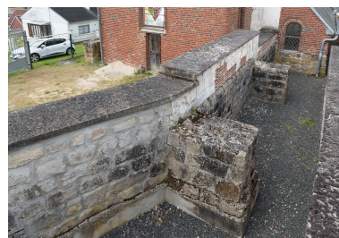
Emprise de l'ancien chevet avec les bases des contreforts. Phot. Marc Kérignard IVR32_20246000660NUCA
