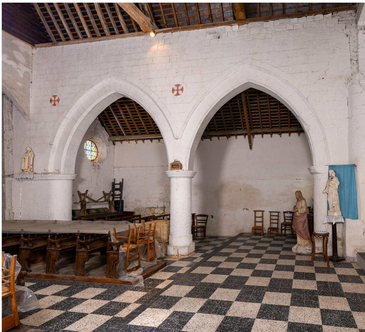
Vue intérieure vers la chapelle nord.
