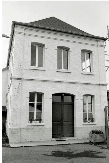
Élévation principale des bureaux, en 1990. Phot. Francis Dubuc IVR22_19908000188Z
