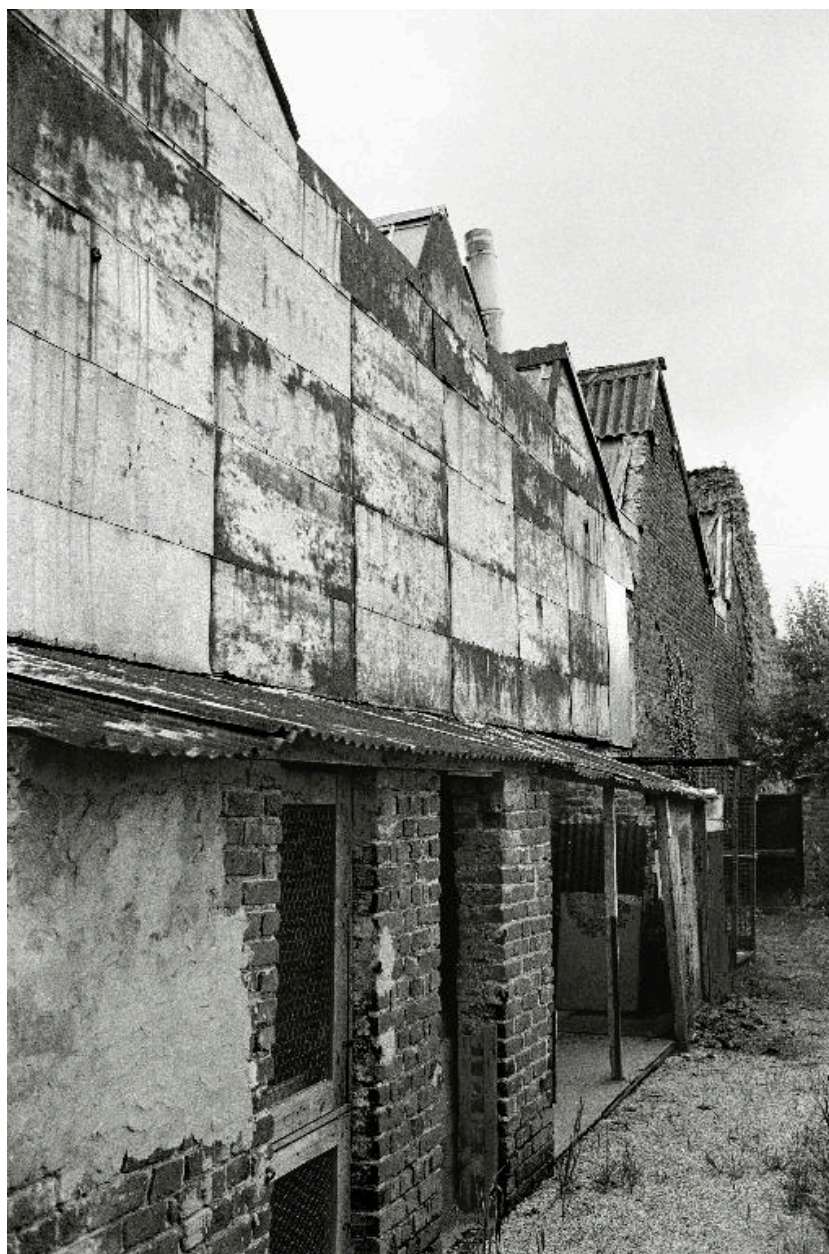
Elévation postérieure des ateliers de fabrication, en 1990.
