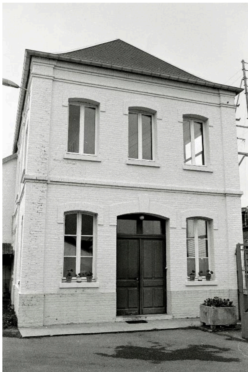
Elévation principale des bureaux, en 1990.
