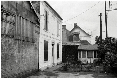
Logement patronal, vue partielle, en 1990. Phot. Francis Dubuc IVR22_19908000184Z
