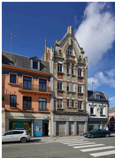
Vue générale de la façade principale depuis la rue de Péronne. Phot. Hubert Bouvet IVR32_20196200575NUC4A
