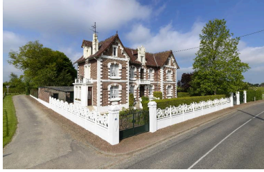
Vue de trois-quarts. Phot. Thierry Lefébure IVR22_20158000355NUC2AQ
