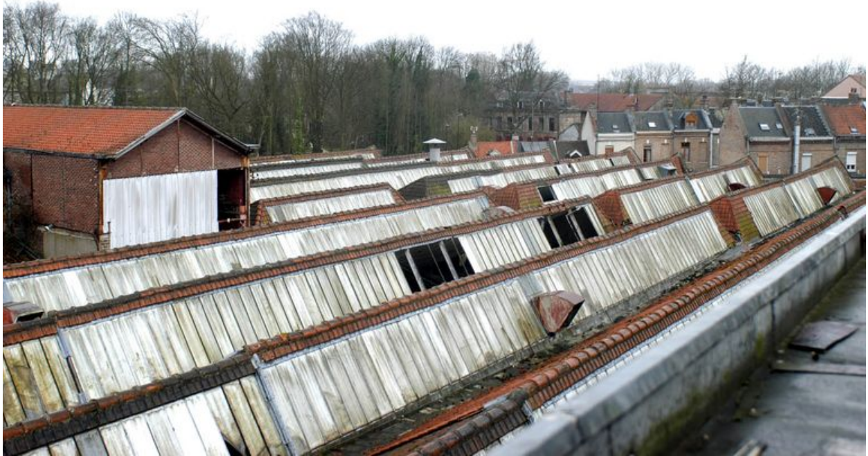
Vue des toitures.
