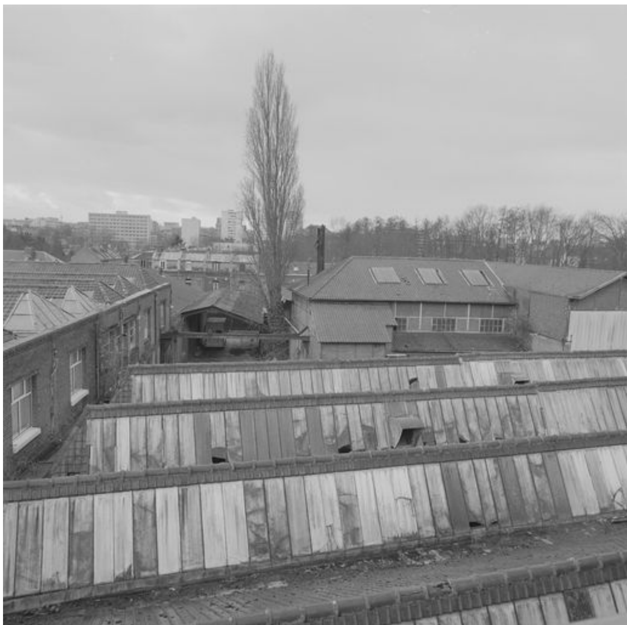
Vue des toitures.
