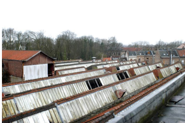
Vue des toitures. Phot. Thierry Lefébure IVR22_20038001099NUCA
