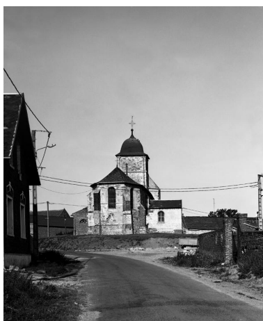
Vue du chevet. Phot. Thierry Lefébure IVR22_19910201402V
