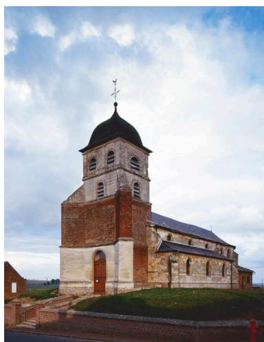
Vue d'ensemble, depuis l'ouest. Phot. Thierry Lefébure IVR22_19910202027VA
