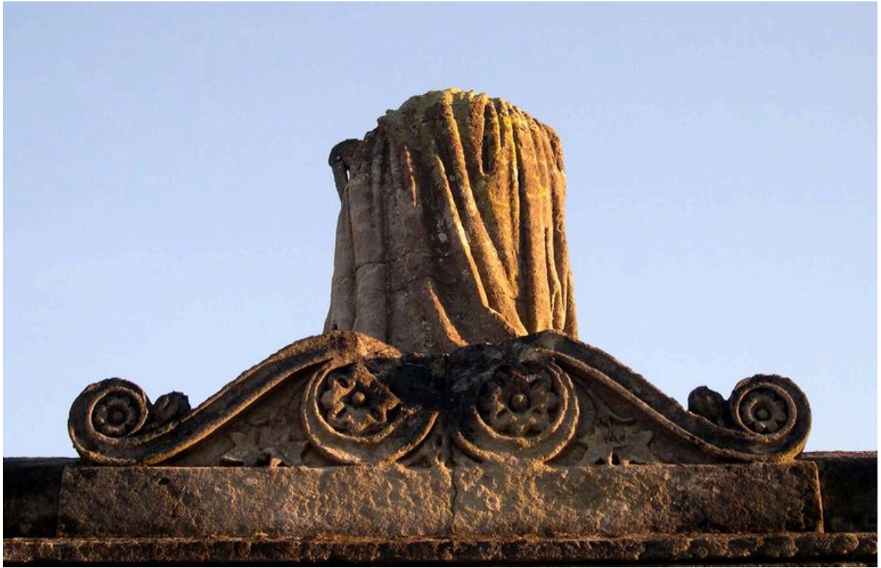
Vue de détail du couronnement, face nord.
