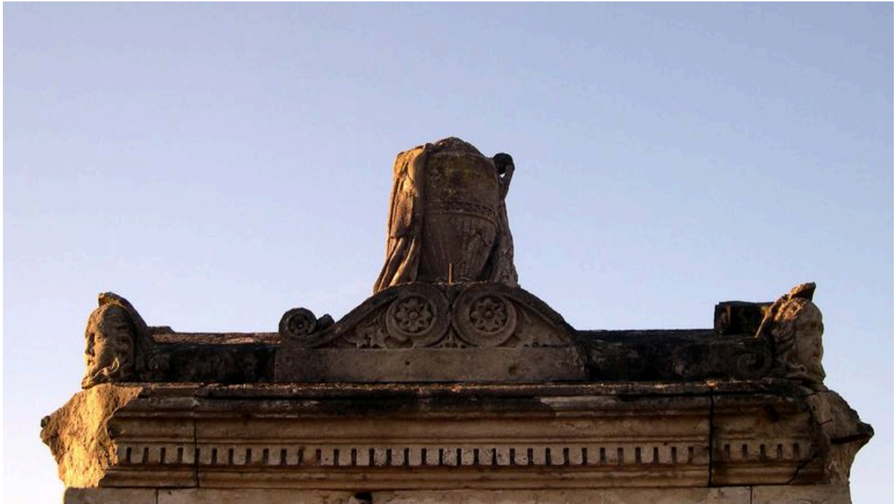
Vue de détail du couronnement, face sud.
