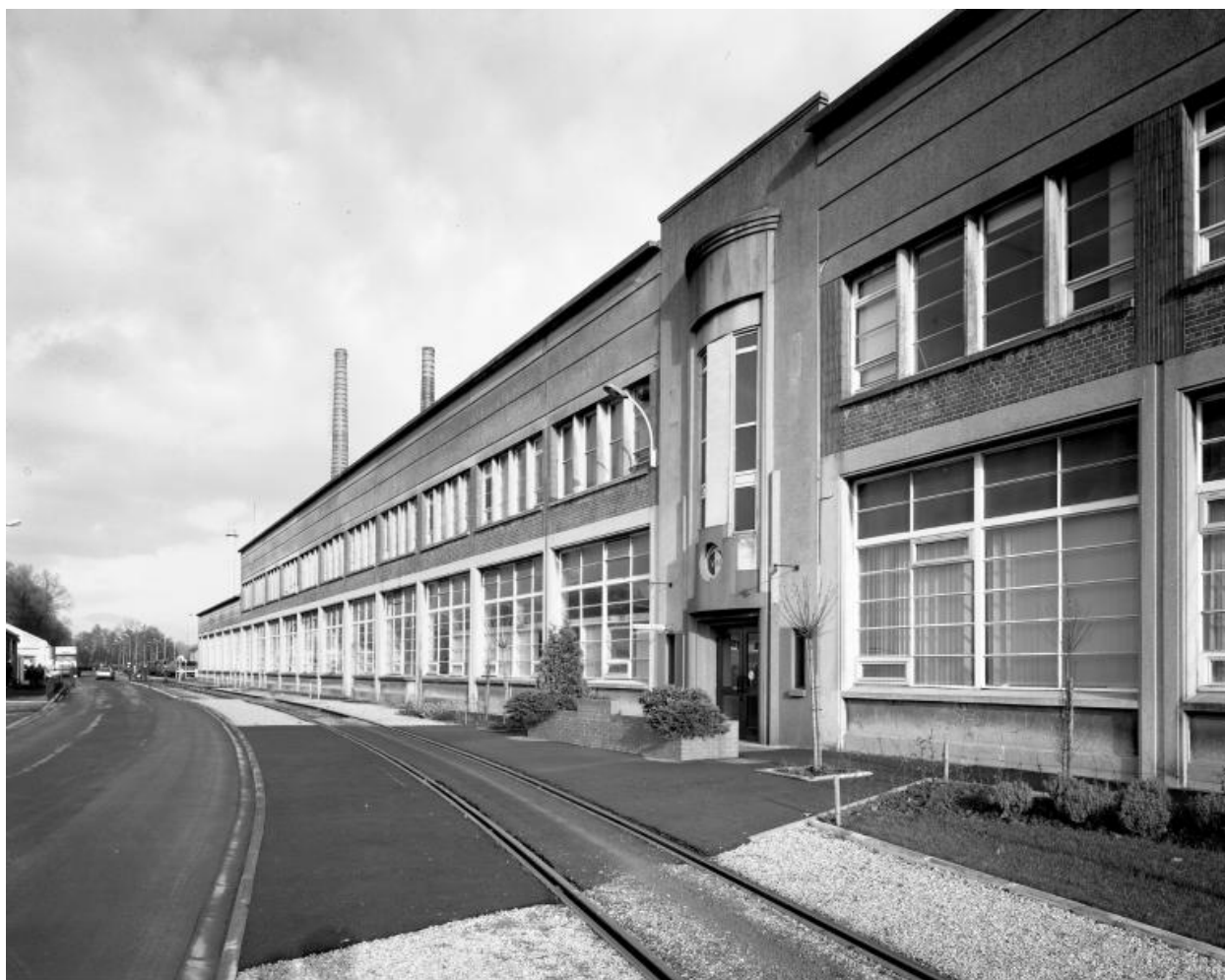
Vue générale partielle des bureaux de la tuberie (usine C).
