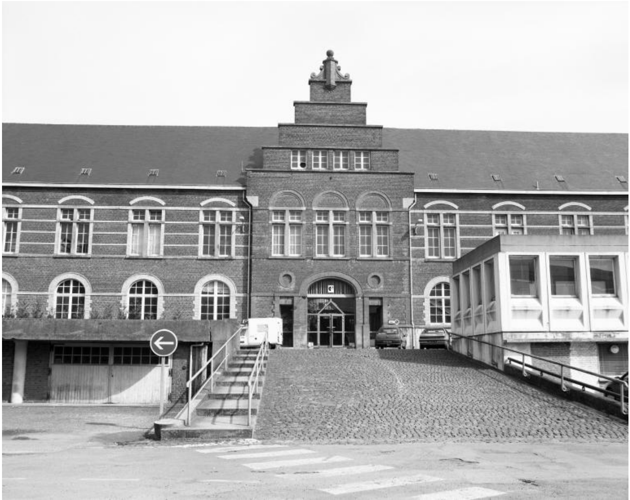
Élévation postérieure des grands bureaux. L'entrée (façade-pignon).
