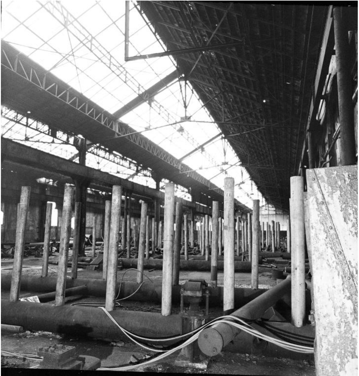
Aire de stockage des tubes (usine B).
