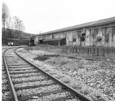
Ateliers, élévation est (usine B). Phot. Olivier Marlard IVR31_19905900068X
