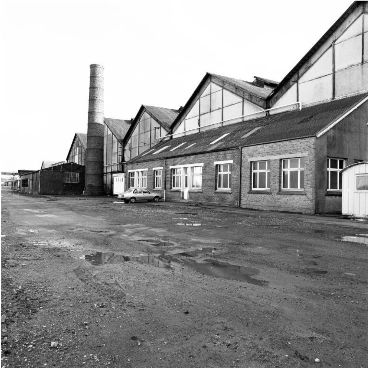
Élévation nord des ateliers et cheminée (usine B).
