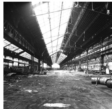
La "vieuse" usine (B) avant sa destruction partielle. Ateliers. Vue intérieure. Phot. Olivier Marlard IVR31_19905900073X
