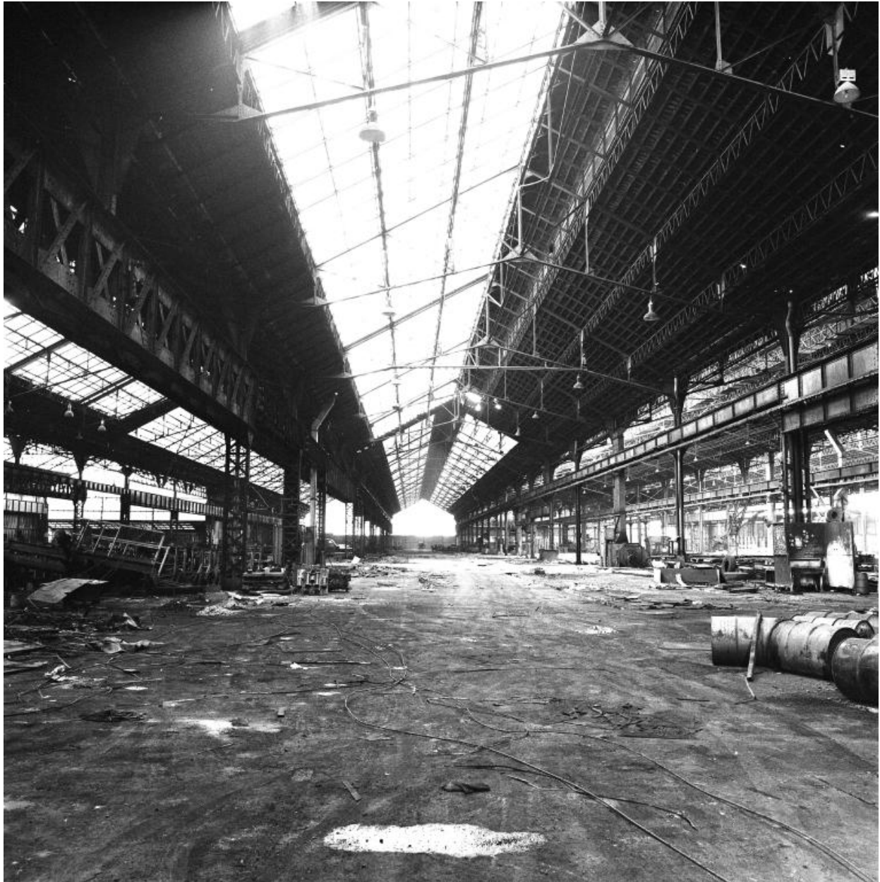
La "vieille" usine (B) avant sa destruction partielle. Ateliers. Vue intérieure.
