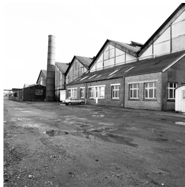
Élévation nord des ateliers et cheminée (usine B). Phot. Olivier Marlard IVR31_19905900074X
