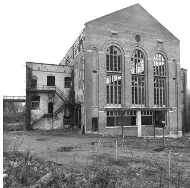
La centrale électrique en 1990, vue depuis le sud (usine B). Phot. Olivier Marlard IVR31_19905900066X
