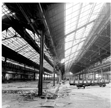
Vue intérieure des ateliers (usine B). Phot. Olivier Marlard IVR31_19905900072X
