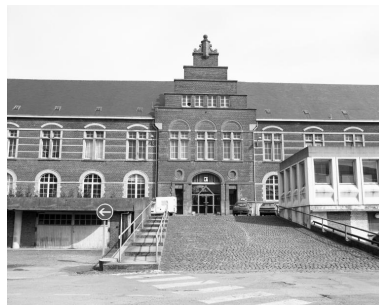
Élévation postérieure des grands bureaux. L'entrée (façade-pignon). Phot. Thierry Petitberghien IVR31_20025901227X
