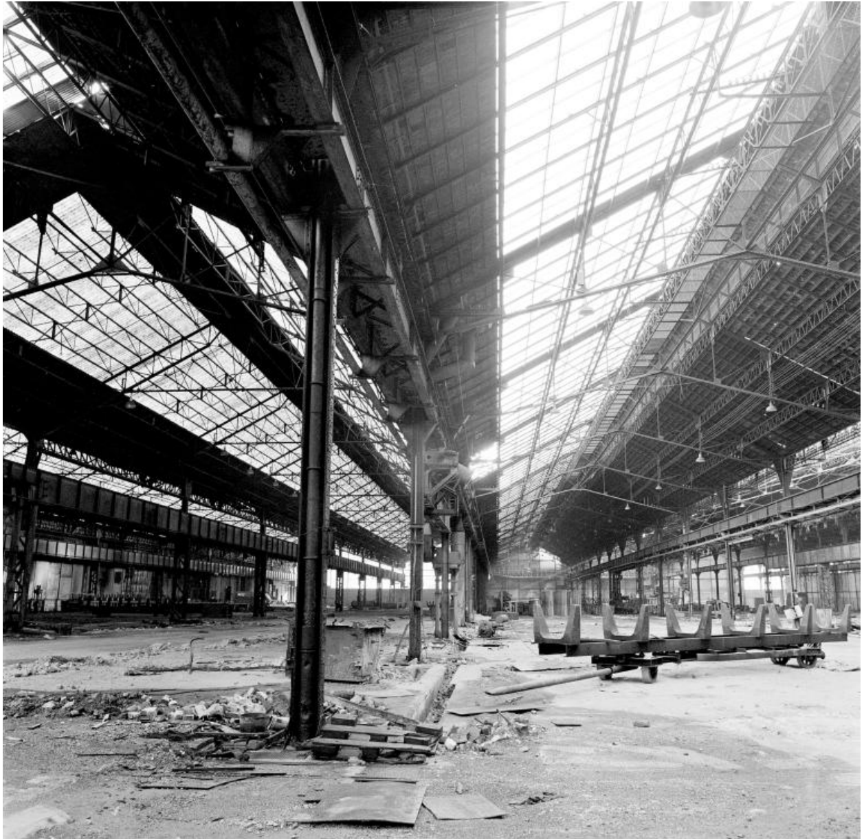
Vue intérieure des ateliers (usine B) .
