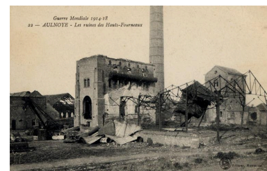
Les ruines des hauts fourneaux (usine A) après la Première Guerre mondiale. Carte postale, L.S. (éditeur à Hautmont), [ca 1900] (coll. part.). Repr. Jean-Marc Ramette IVR32_20205902684NUCA
