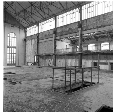
La centrale électrique en 1990, premier niveau (usine B). Phot. Olivier Marlard IVR31_19905900064X
