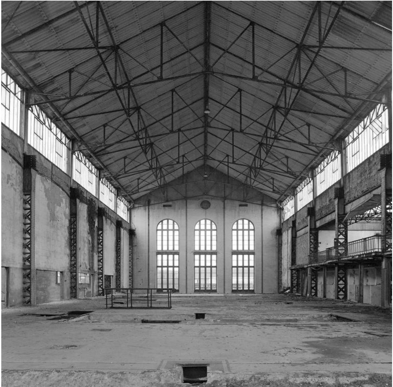
La centrale électrique en 1990 (usine B).
