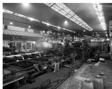
Les laminoirs (usine C). Vue générale des lisseurs. Phot. Thierry Petitberghien IVR31_20025900341V
