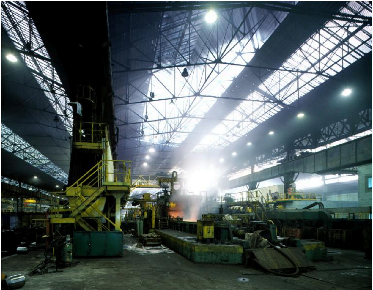
Les laminoirs (usine C). Vue générale de l'élongateur. Sortie du tube.
