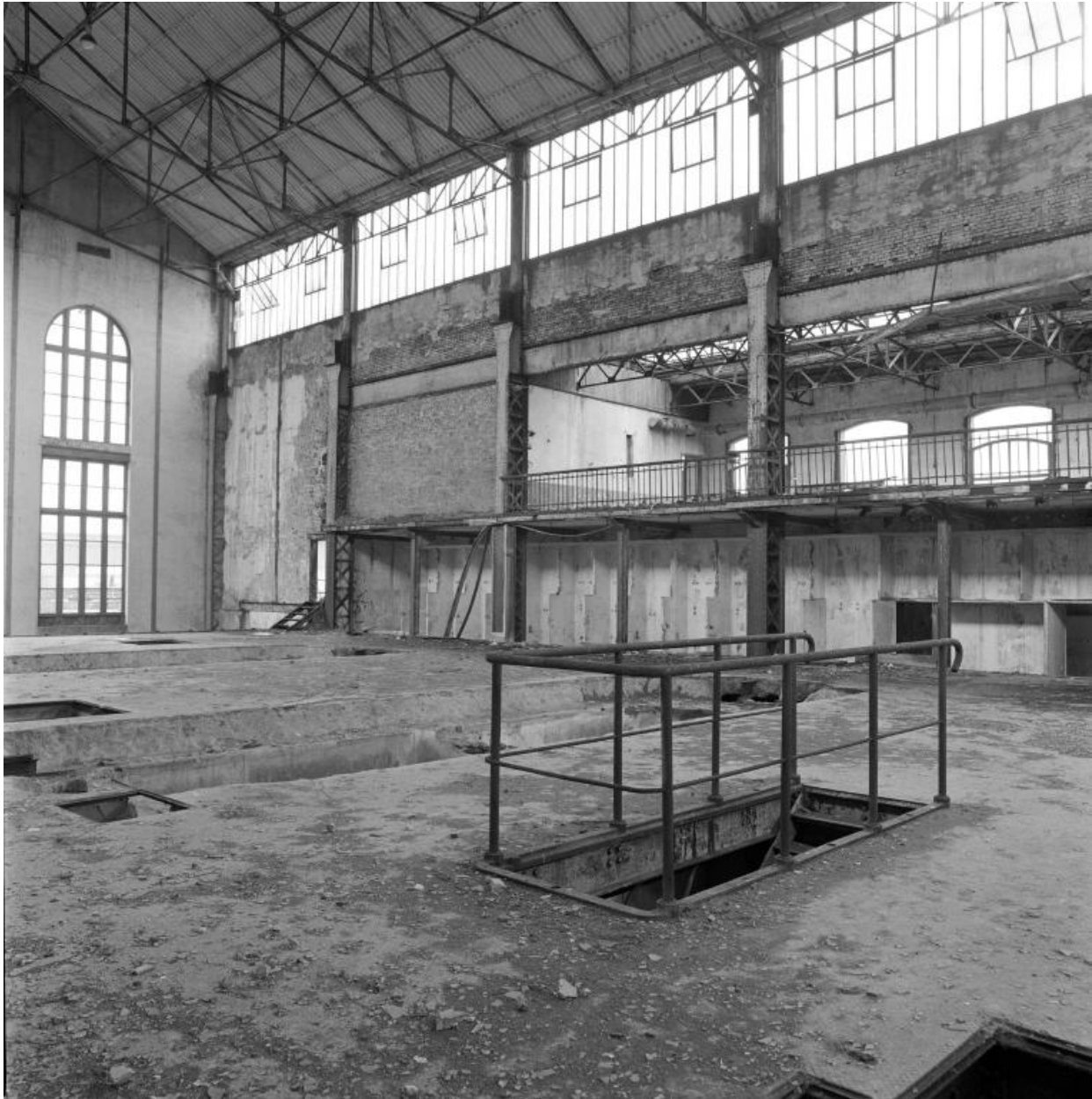
La centrale électrique en 1990, premier niveau (usine B).
