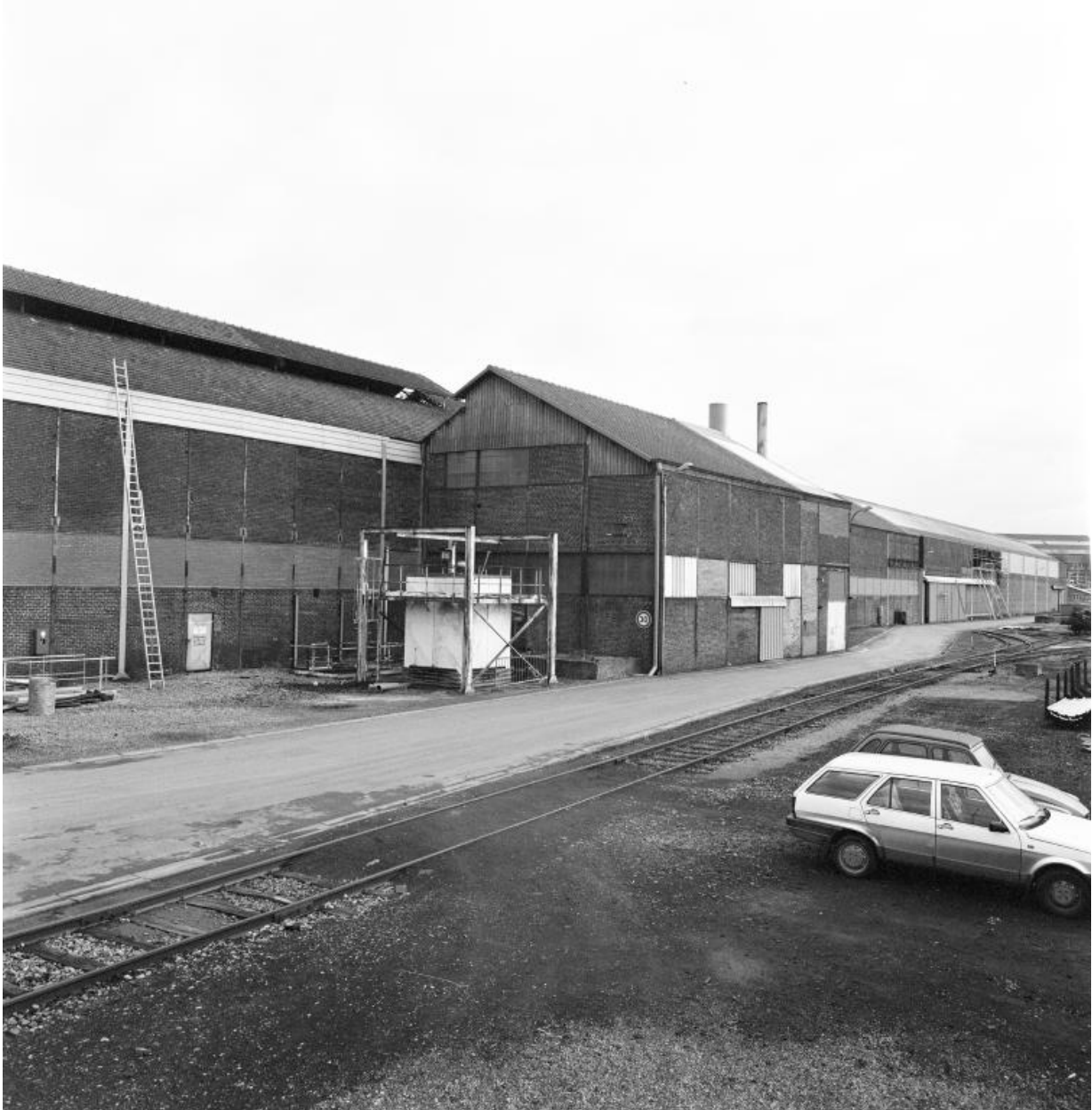
Ateliers, élévation ouest (usine B).
