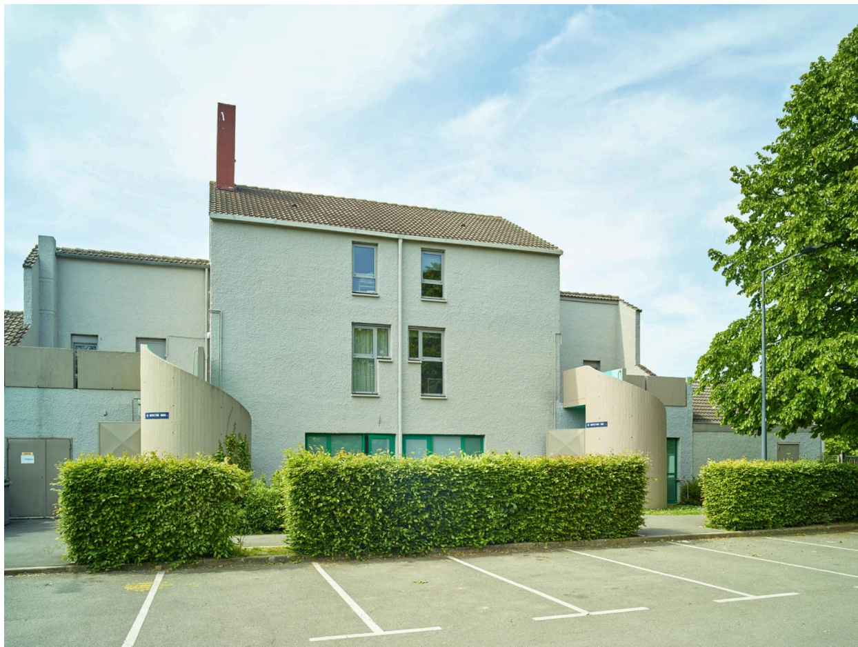
Les logements de fonction, depuis la placette située à l'est du groupe scolaire.
