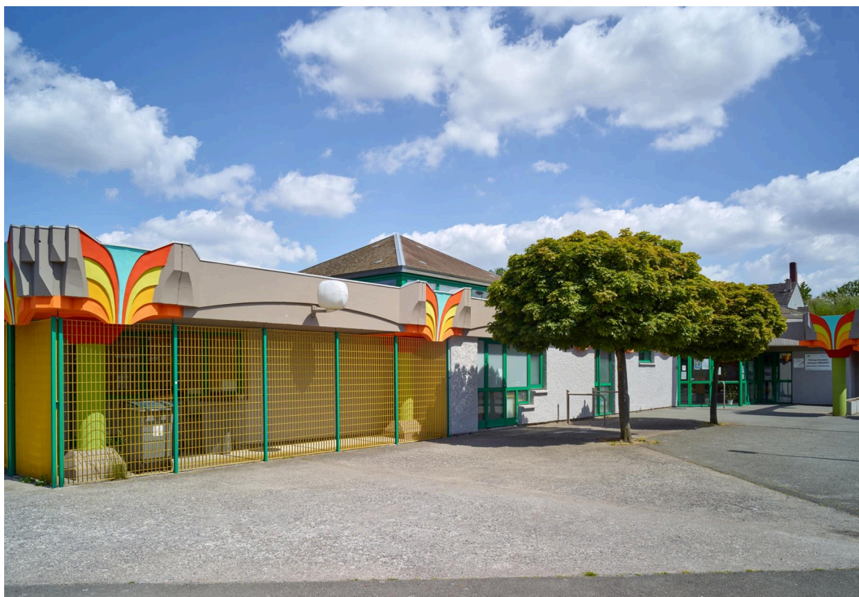
Parvis du groupe scolaire, depuis la rue Jacques-Prévert.
