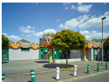
L'entrée du groupe scolaire, donnant sur la rue Jacques-Prévert. Phot. Pierre Thibaut IVR32_20195900386NUCA
