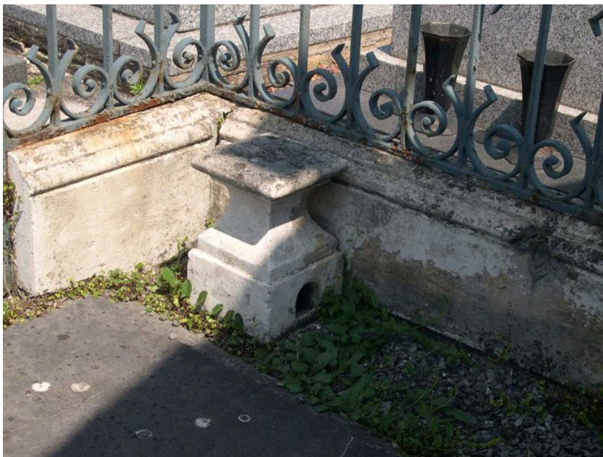
Vue d'une des bouches d'aération du caveau.
