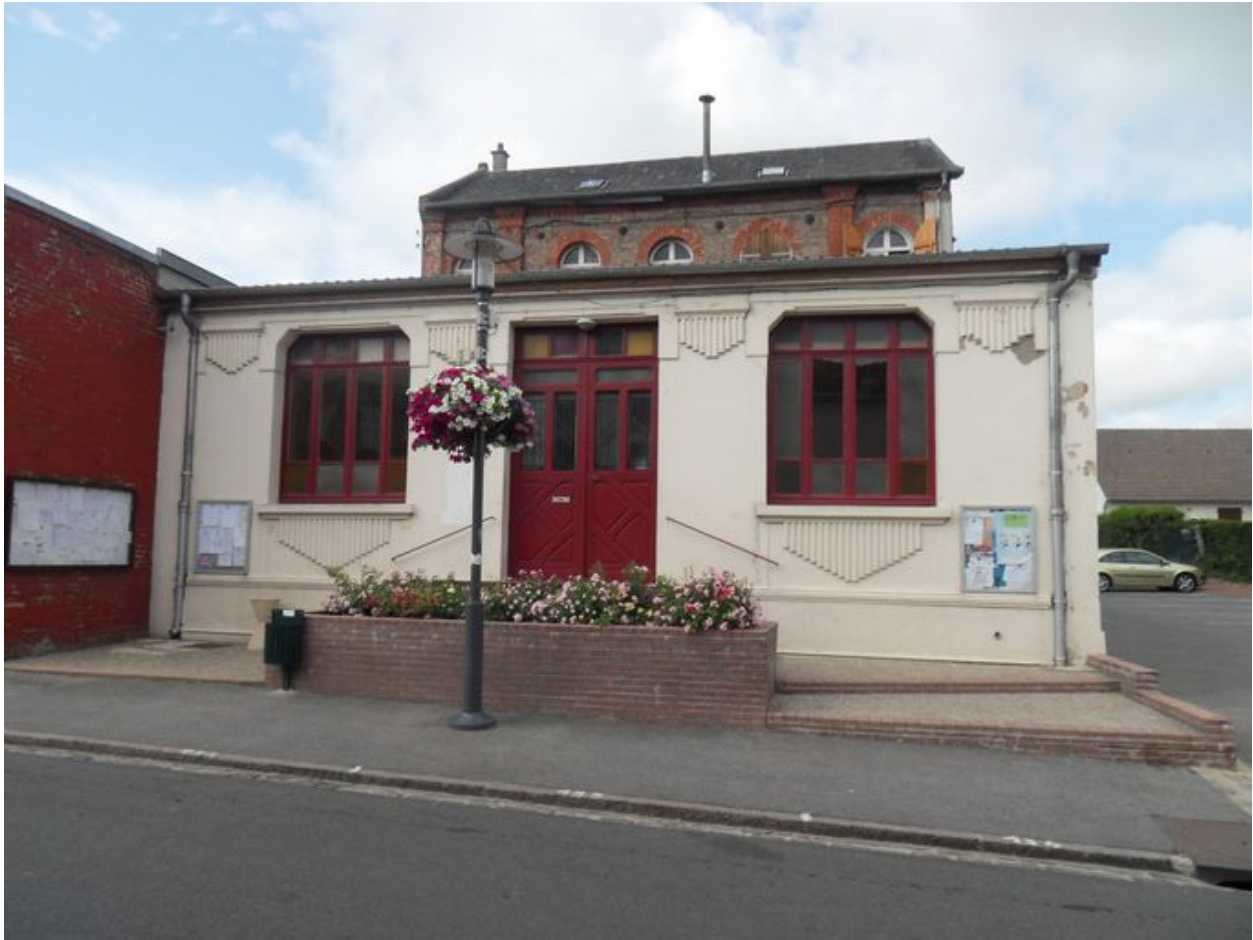
Vue de l'ancienne salle des fêtes.
