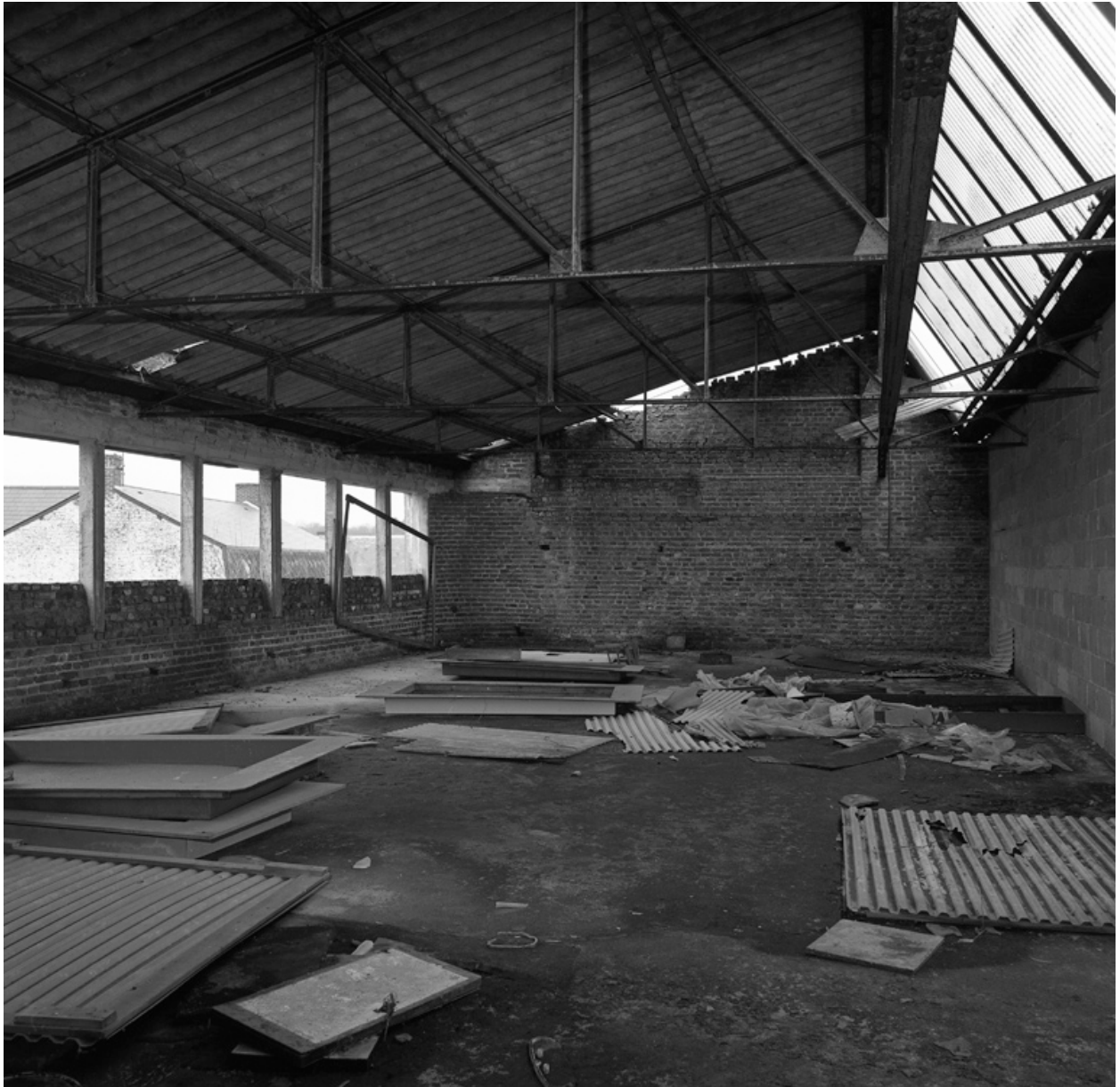
Vue intérieure des anciens ateliers de fabrication.
