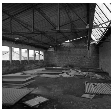
Vue intérieure des anciens ateliers de fabrication. Phot. Thierry Lefébure IVR22_19960200060X
