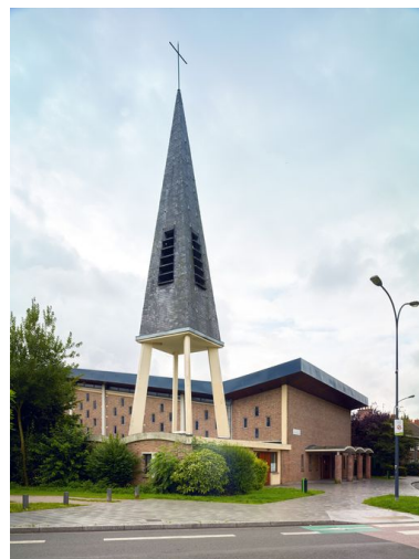
Vue générale de la tour clocher. Phot. Pierre Thibaut IVR31_20155901544NUCA
