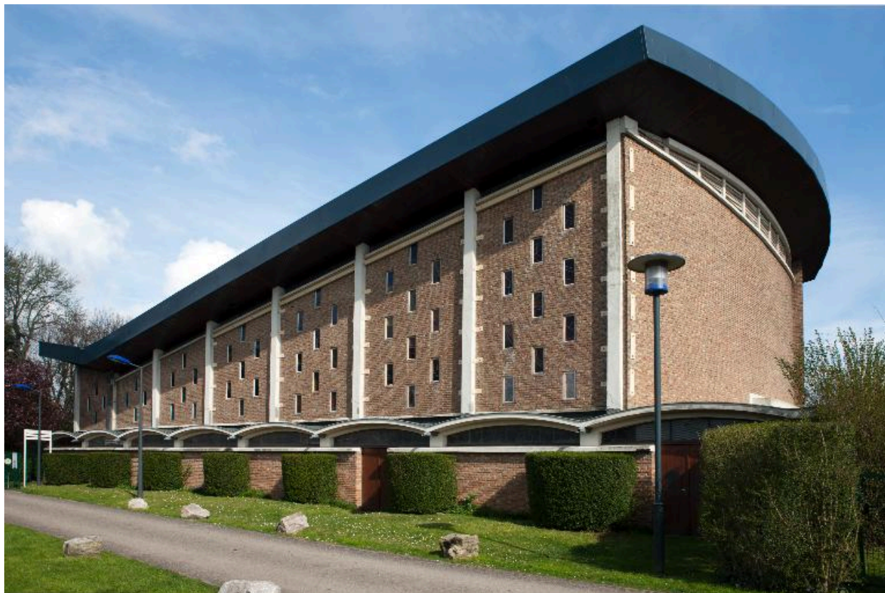
Vue générale de l'élévation de la nef.
