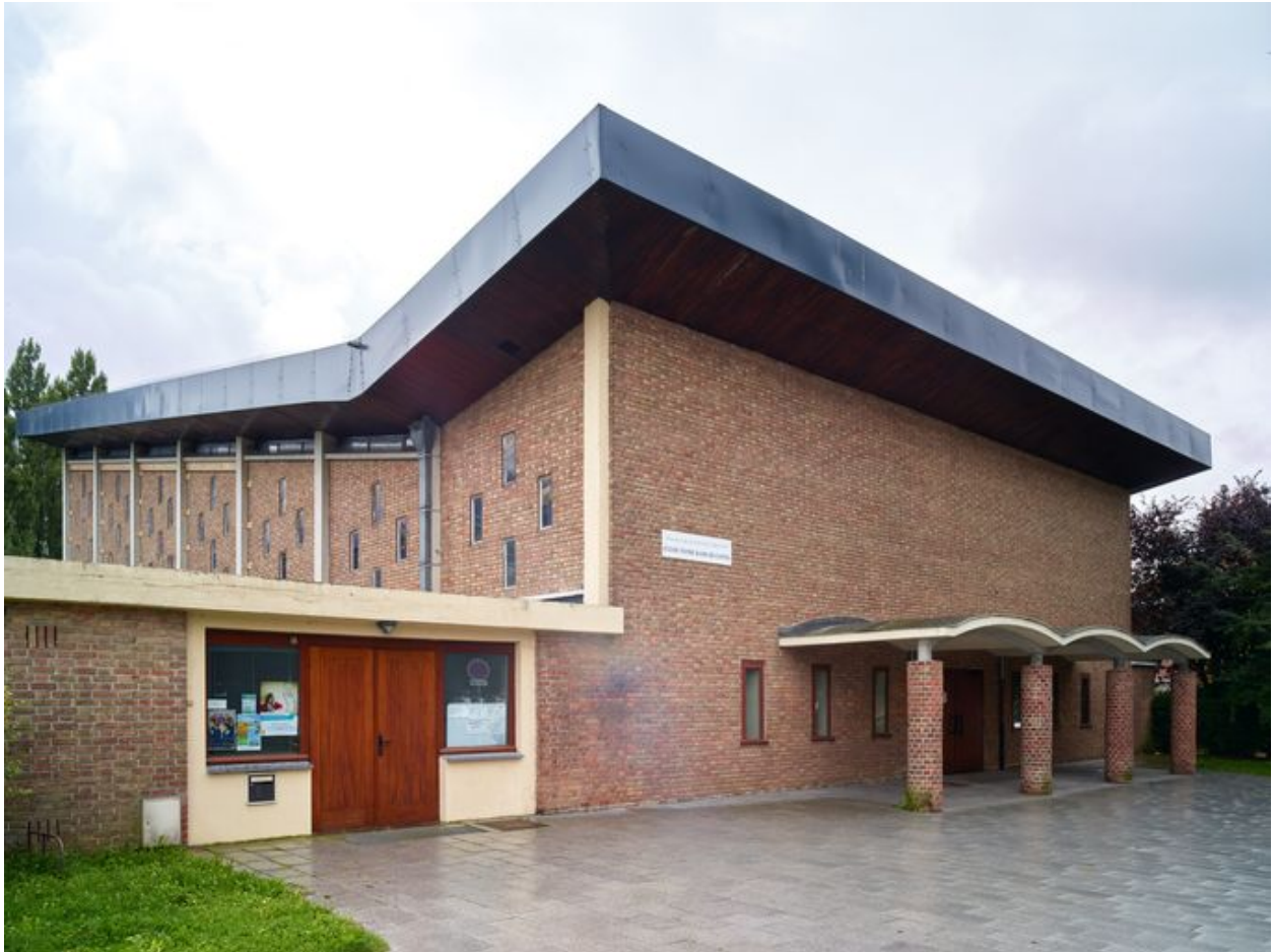
Vue de trois quart de la façade de l'église, avec son entrée.
