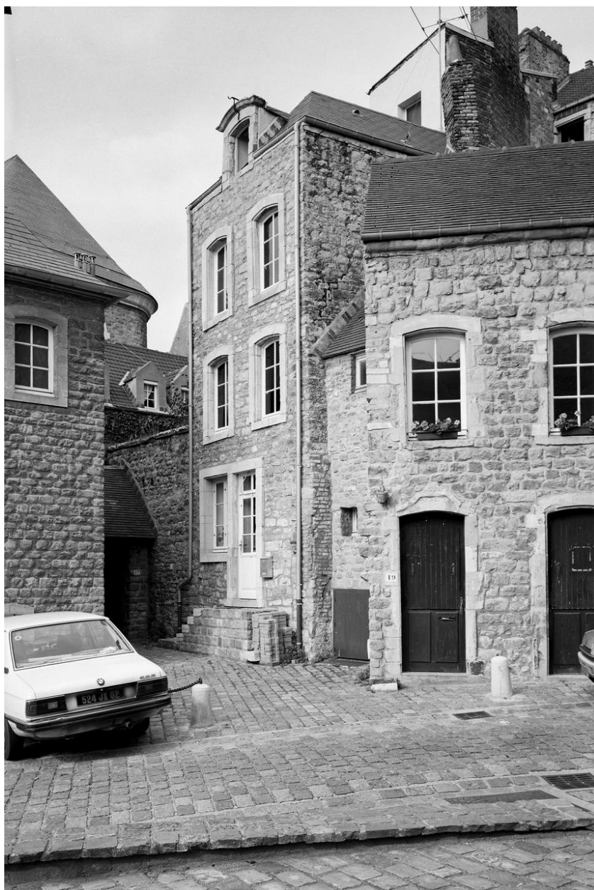
Angle sud-ouest après restauration.
