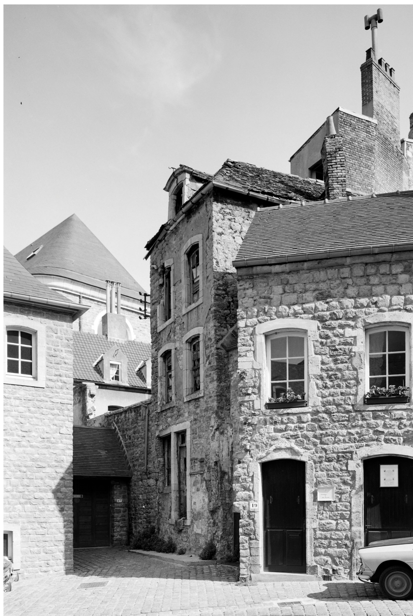
Façade sur voie avant restauration.
