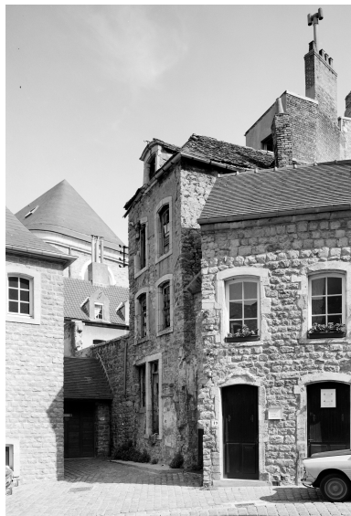
Façade sur voie avant restauration.
