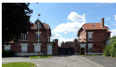
L'ancienne conciergerie et le logement du directeur.
