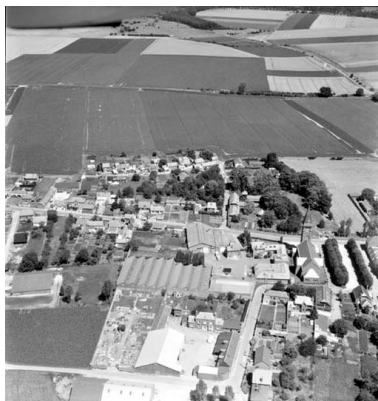
Vue aérienne, flanc sud.
