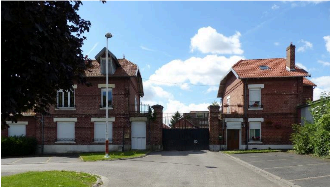
L'ancienne conciergerie et le logement du directeur.
