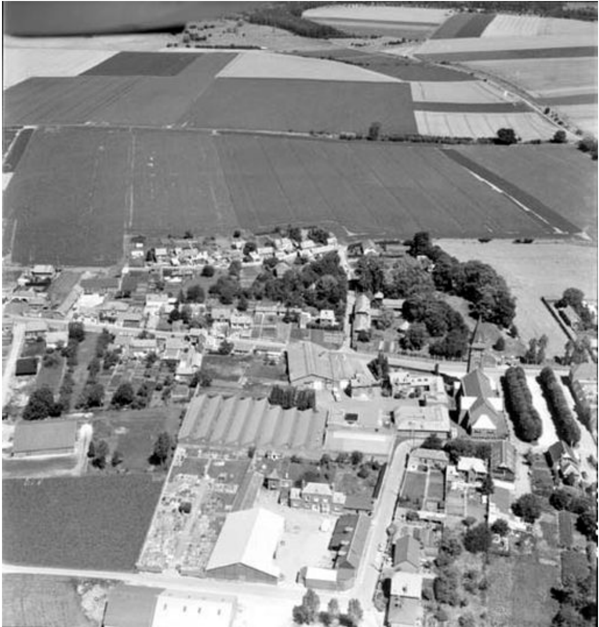
Vue aérienne, flanc sud.
