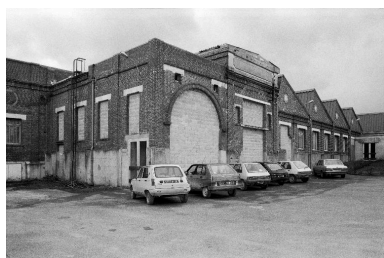
Anciennement chaufferie, salle des machines, atelier de fabrication. Elévation antérieure.
