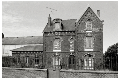
Vue générale depuis la rue en 1990 Phot. Francis Dubuc IVR22_19908000104Z
