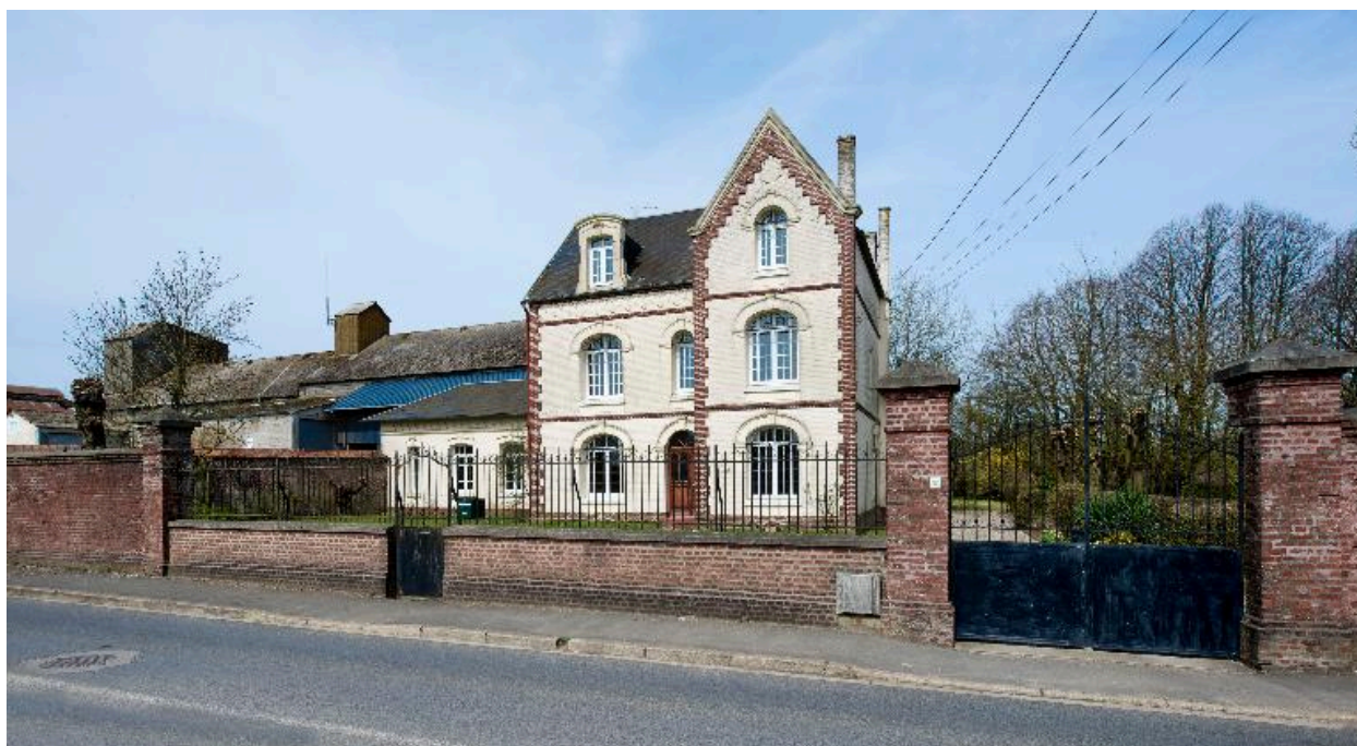
Vue générale depuis la rue Victor Hugo
