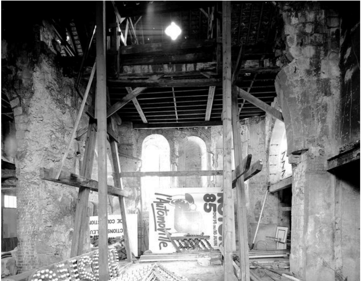
Vue intérieure vers l'est.
