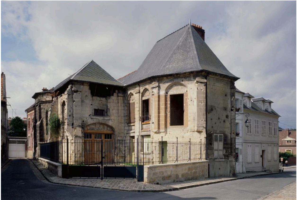
Vue générale nord-est.
