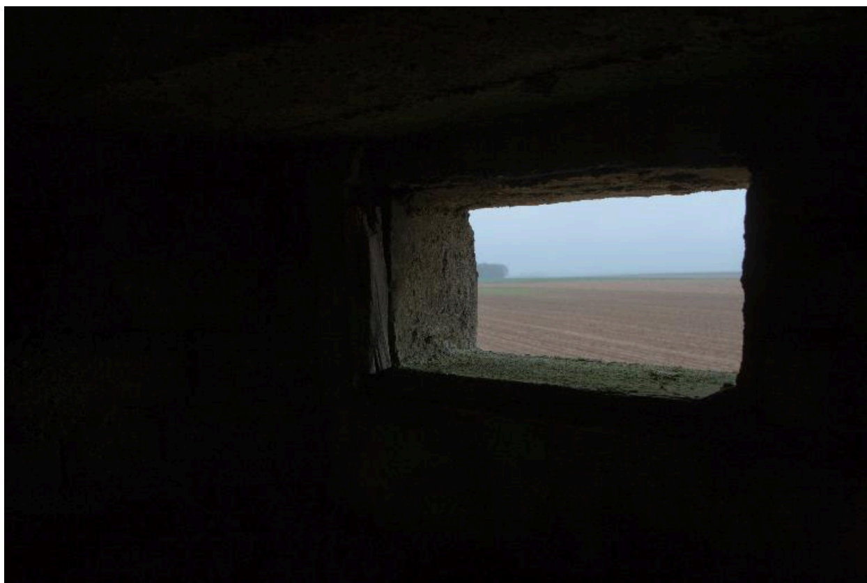
Vue de détail d'une ouverture.
