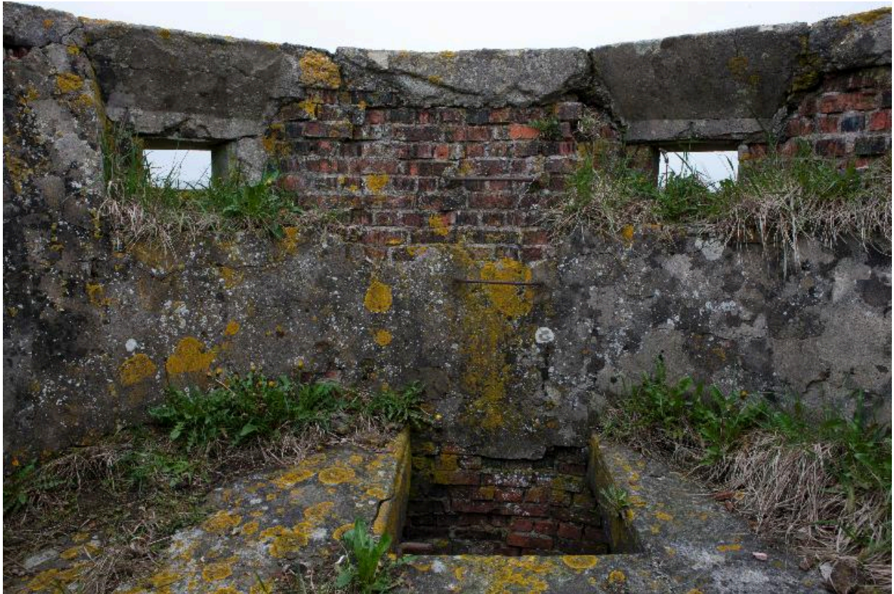
Vue de détail du dernier étage.
