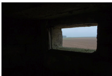
Vue de détail d'une ouverture. Phot. Pierre Thibaut IVR31_20126201766NUCA
