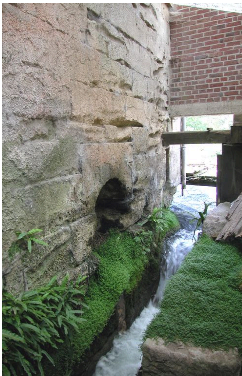
Vue intérieure de la cage du moulin, détail du coursier.
