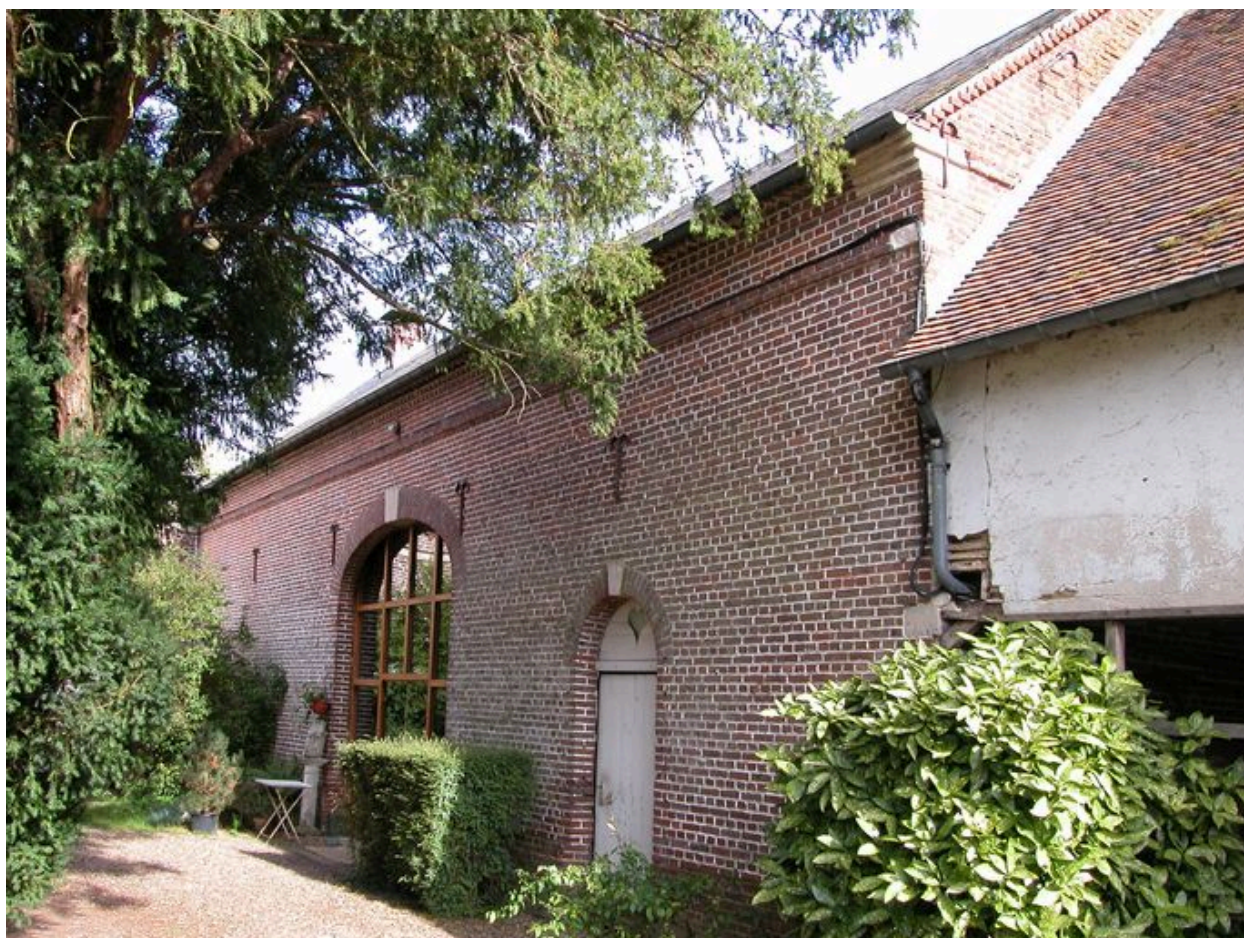
Les granges, façade sur cour.
