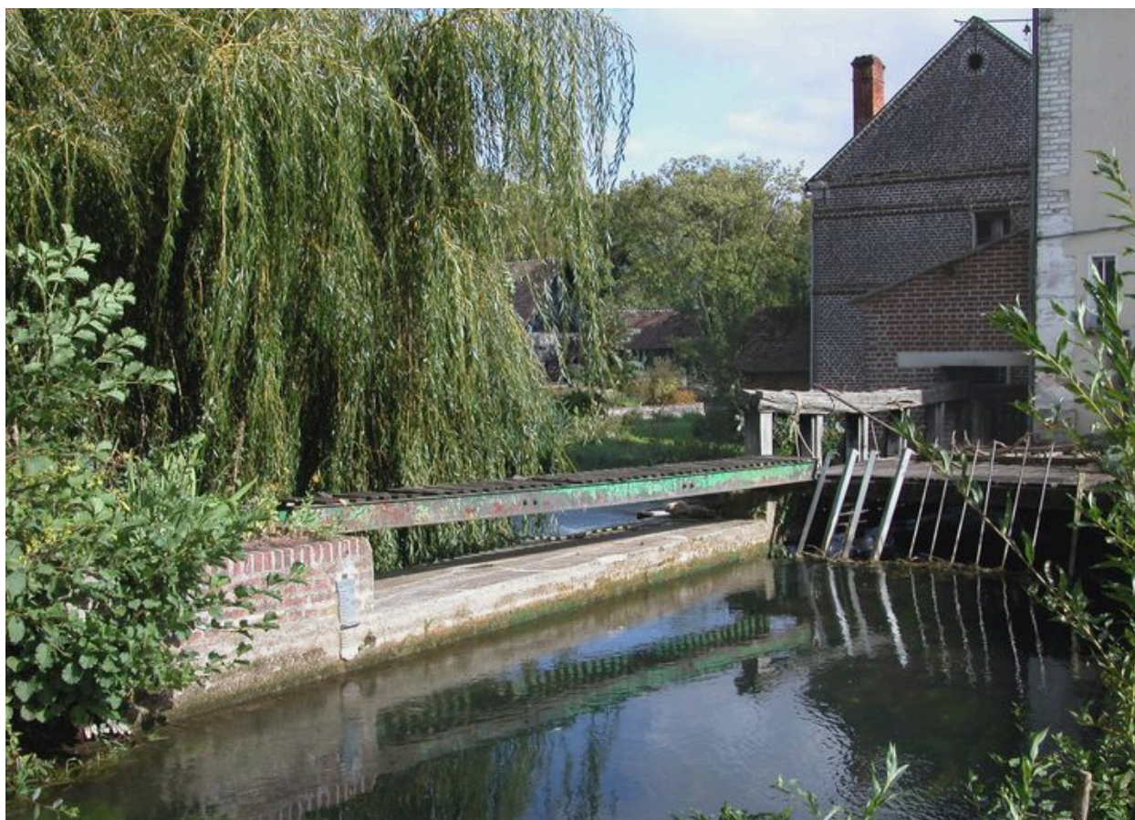
Le déversoir et le vannage de décharge.
