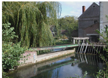
Le déversoir et le vannage de décharge. Phot. Bertrand Fournier IVR22_20046002978NUCA
