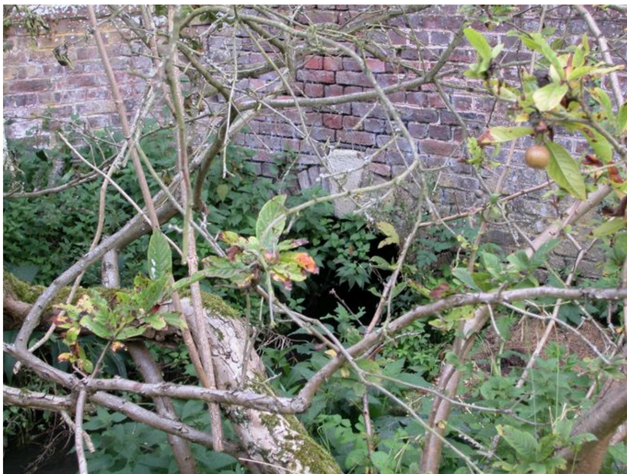
La sortie du canal de fuite.
