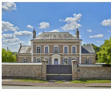
Vue de la maison, depuis le nord. Phot. Thierry Lefébure IVR32_20258001394NUCA
