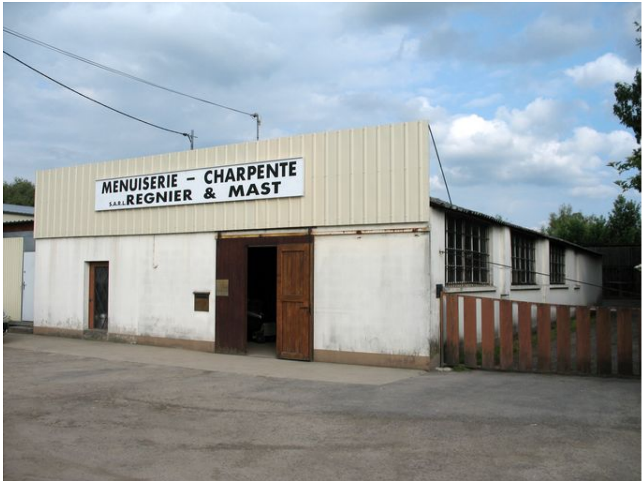
Vue générale de la menuiserie.
