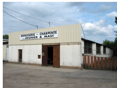
Vue générale de la menuiserie.
