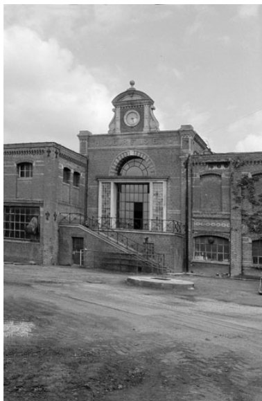
Salle des machines. Phot. Benoît Dufournier IVR22_19878000043Z
