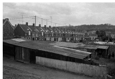
La cité ouvrière (ruelle Rouse), flanc ouest. Phot. Benoît Dufournier IVR22_19878000053Z
