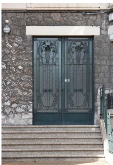
Porte en fer forgé ornée de spirales et de fleurs stylisées. Phot. Pierre Thibaut IVR31_20096200176NUCA
