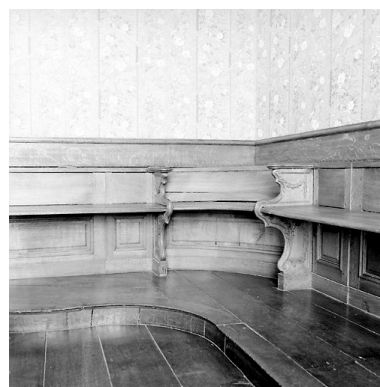
Détail : lambris d'appui et bancs fixes. Phot. Pierre Thibaut IVR31_20055900826X
