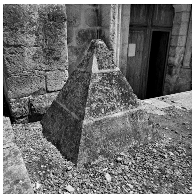
Vue générale du monument. Phot. Christiane Riboulleau IVR22_19880200931X
