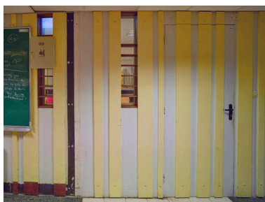
Vue rapprochée des glaces et des bois coloniaux de la banque d'accueil du hall, à l'intersection entre les deux ailes du C.E.T. Phot. Pierre Thibaut IVR32_20176200083NUCA
