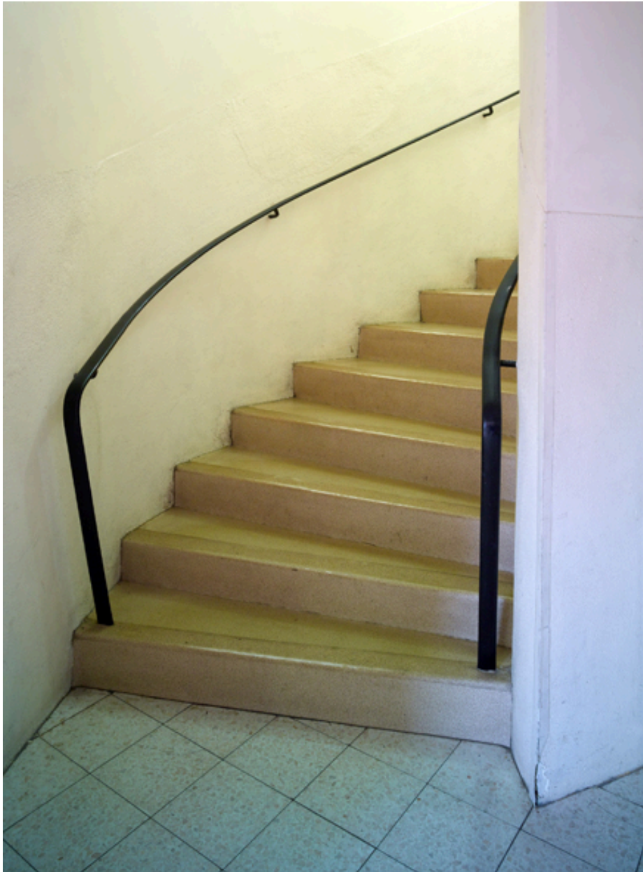
Vue du début d'une volée de l'escalier à double révolution de la tour de l'internat.
