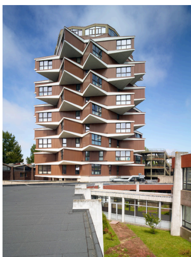
Vue de la liaison entre le C.E.S. et le C.E.T., depuis la toiture du C.E.T., vers l'élévation sud de la tour de l'internat.
