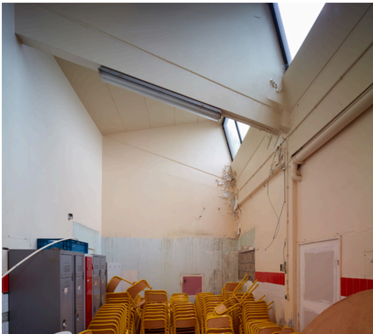
Vue de la toiture à redans depuis l'intérieur des anciennes cuisines pédagogiques.
