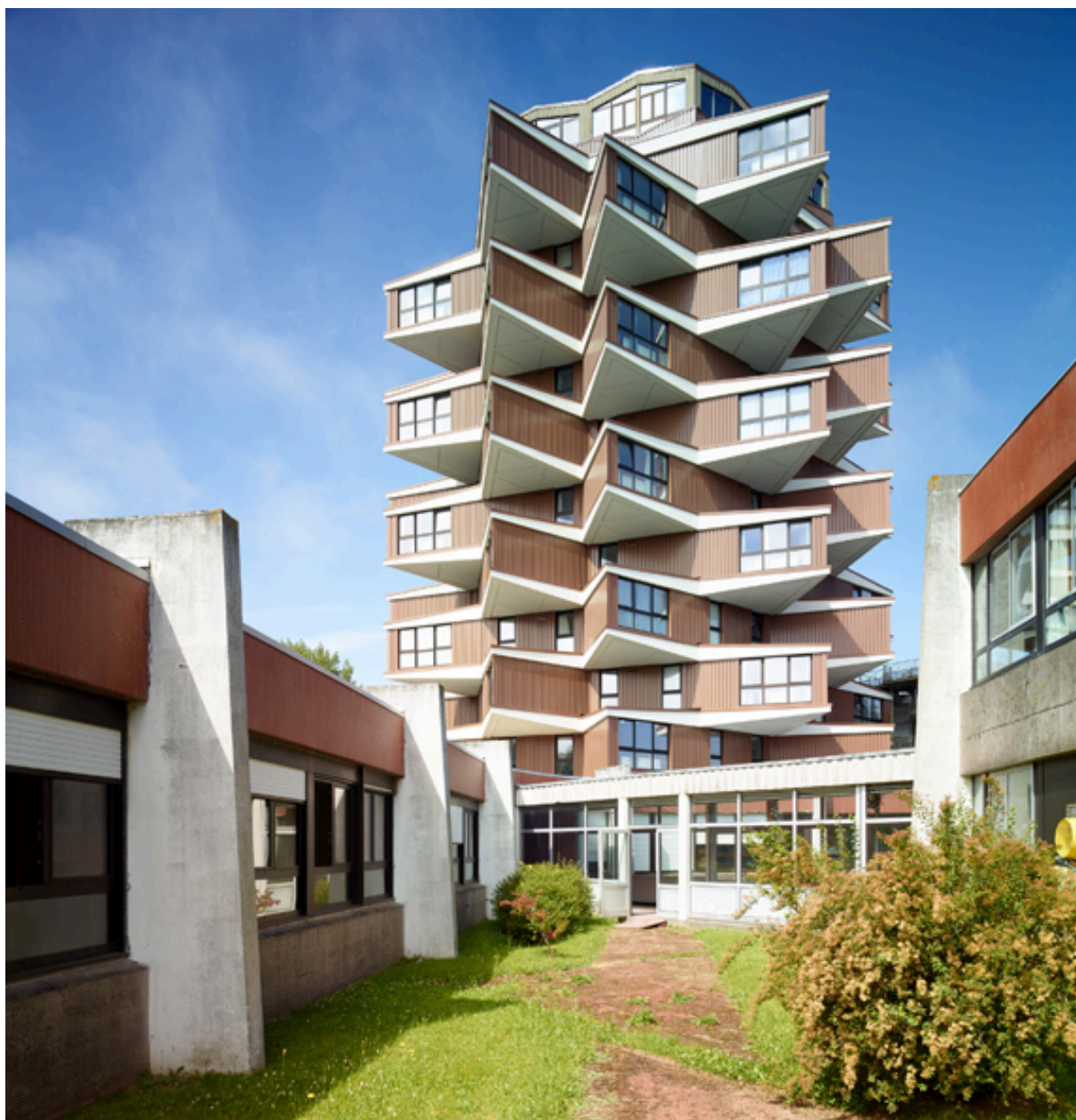
Vue générale de l'élévation sud de la tour de l'internat et de la liaison entre le C.E.S. et le C.E.T., depuis le patio central sud ouest.
