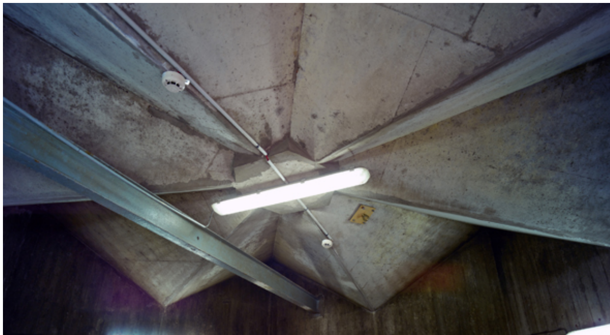
Vue de la sous-face de la toiture du local à machine de l'ascenseur de la tour de l'internat.
