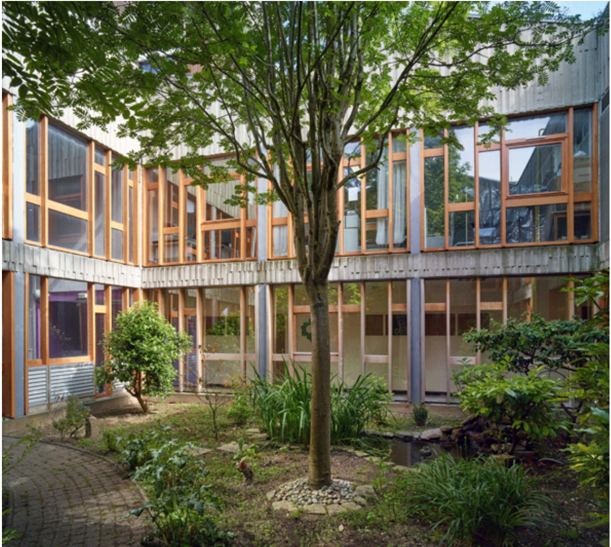
Vue générale du patio des anciennes cuisines du C.E.S., avec les menuiseries originales.
