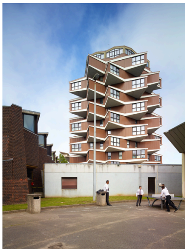
Vue de l'élévation ouest de la tour de l'internat et des locaux administratifs, depuis la cour du C.E.T.
