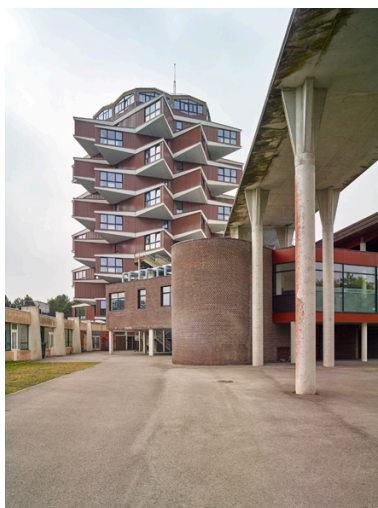
Vue générale depuis le sud est, de la tour de l'internat, des poteaux de la rampe d'accès, et du bâtiment des nouvelles cuisines pédagogiques.
