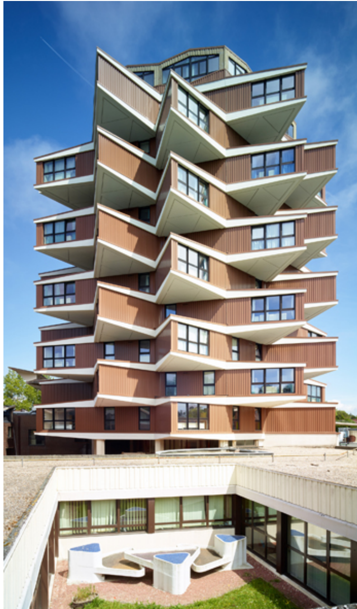
Vue de l'élévation ouest de la tour de l'internat et du patio de l'administration contenant un ensemble de sculptures-fontaines du groupe de l'Œuf, depuis la toiture des locaux administratifs.
