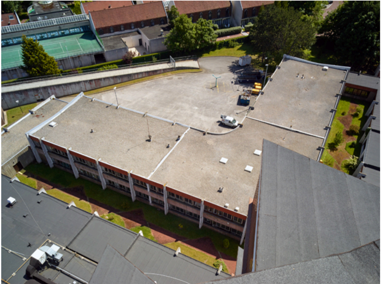
Vue générale du patio central depuis la toiture de la tour de l'internat.
