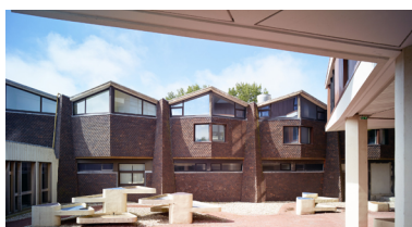
Vue de l'élévation sud des cuisines pédagogiques et de deux ensembles de sculptures-fontaines du groupe de l'Œuf, dans l'ancien patio d'accueil.
