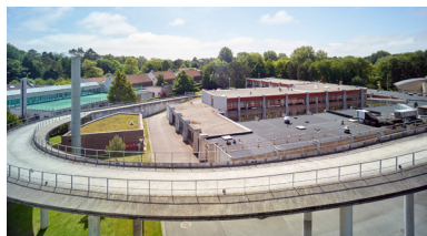
Vue générale des toitures du C.E.S., C.E.T., et de la rampe d'accès, depuis la toiture des logements de fonction.
