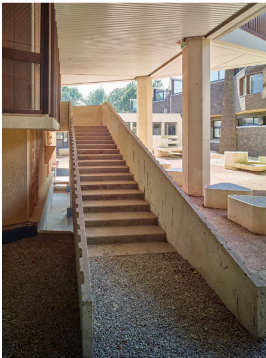
Vue du départ de la rampe d'escalier extérieure menant au niveau de la plate-forme de la tour d'internat, depuis l'ancien patio d'accueil.
