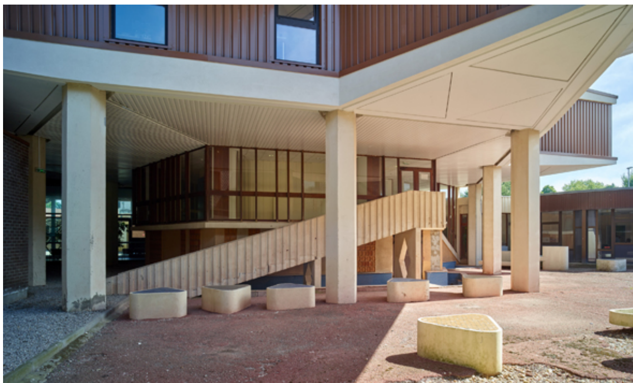
Vue générale de la plate-forme de la tour d'internat au rez-de-chaussée, de la rampe d'escalier extérieure et des assises réalisées par le groupe de l'Œuf, depuis l'ancien patio d'accueil.
