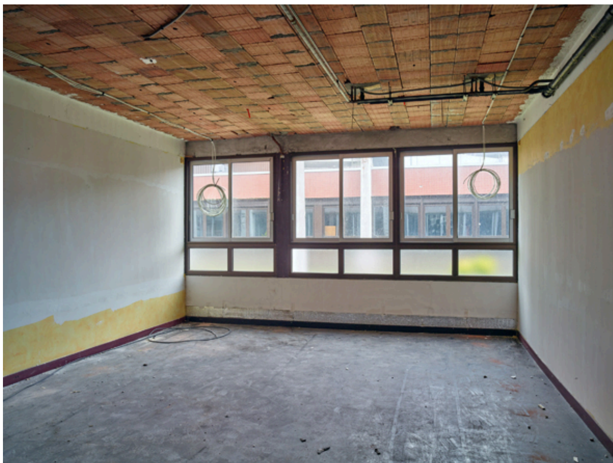
Vue générale d'une ancienne salle de classe du C.E.S., située dans l'aile sud est, donnant sur le patio central.
