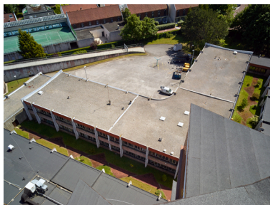
Vue générale du patio central depuis la toiture de la tour de l'internat.
