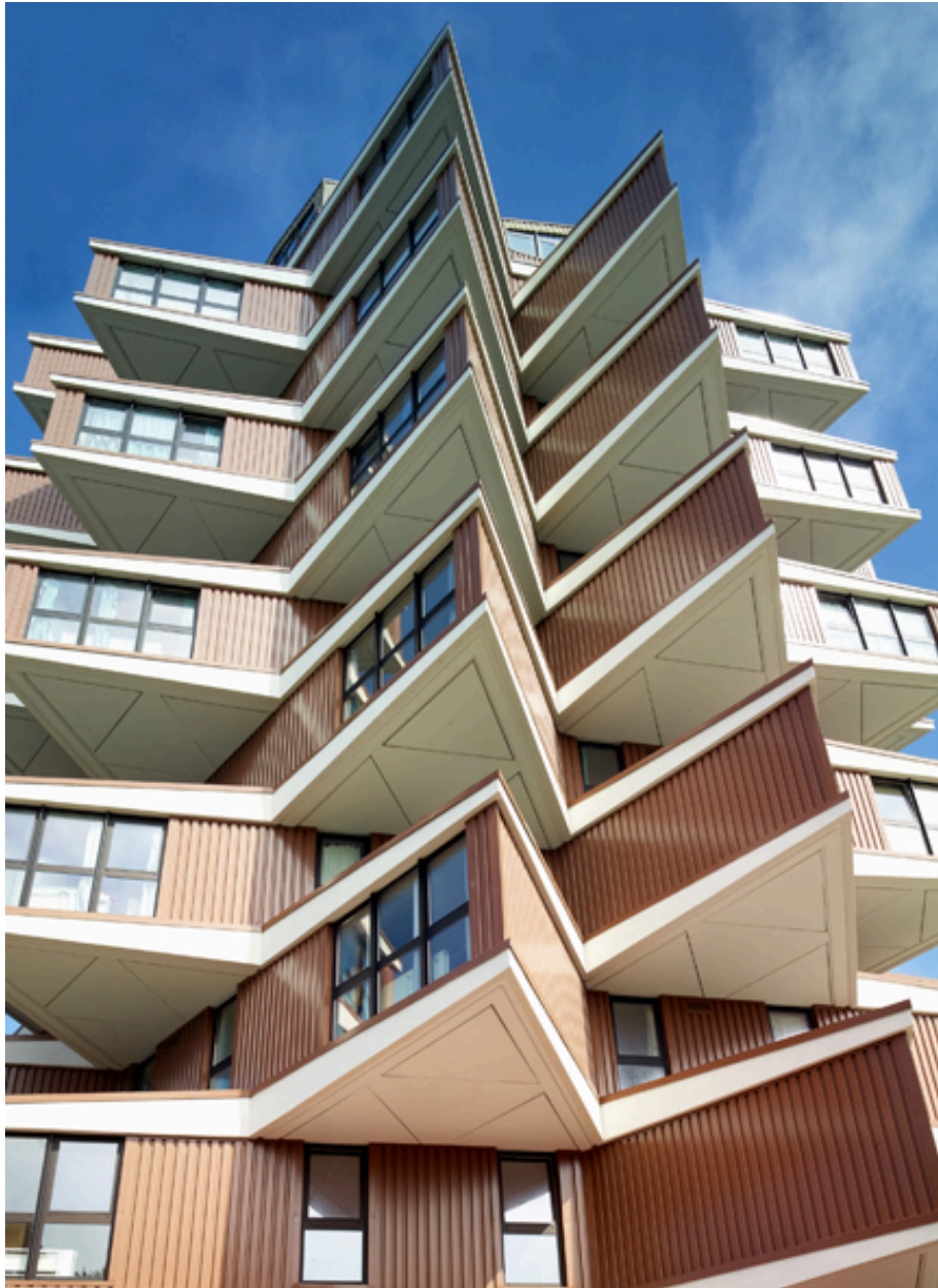
Vue rapprochée de l'élévation ouest de la tour de l'internat, depuis l'ancien patio d'accueil.
