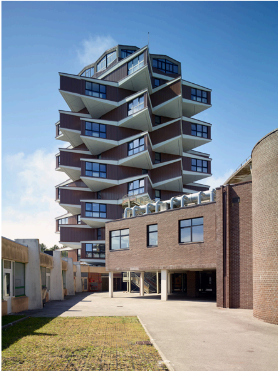
Vue générale depuis le sud est, de la tour de l'internat et du bâtiment des nouvelles cuisines pédagogiques.
