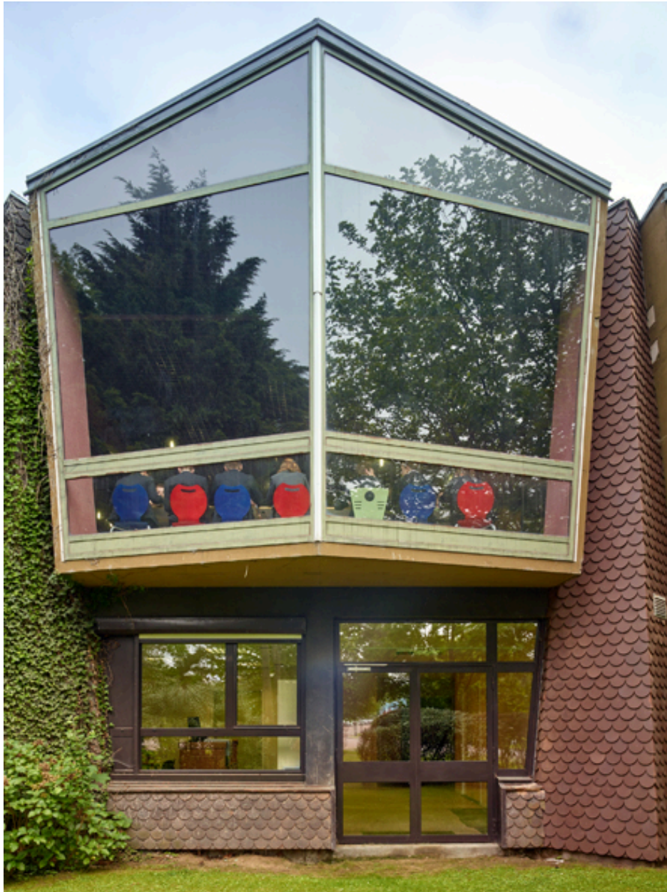
Vue rapprochée de face, d'un module préfabriqué de l'élévation de l'ancien restaurant d'application, côté nord.
