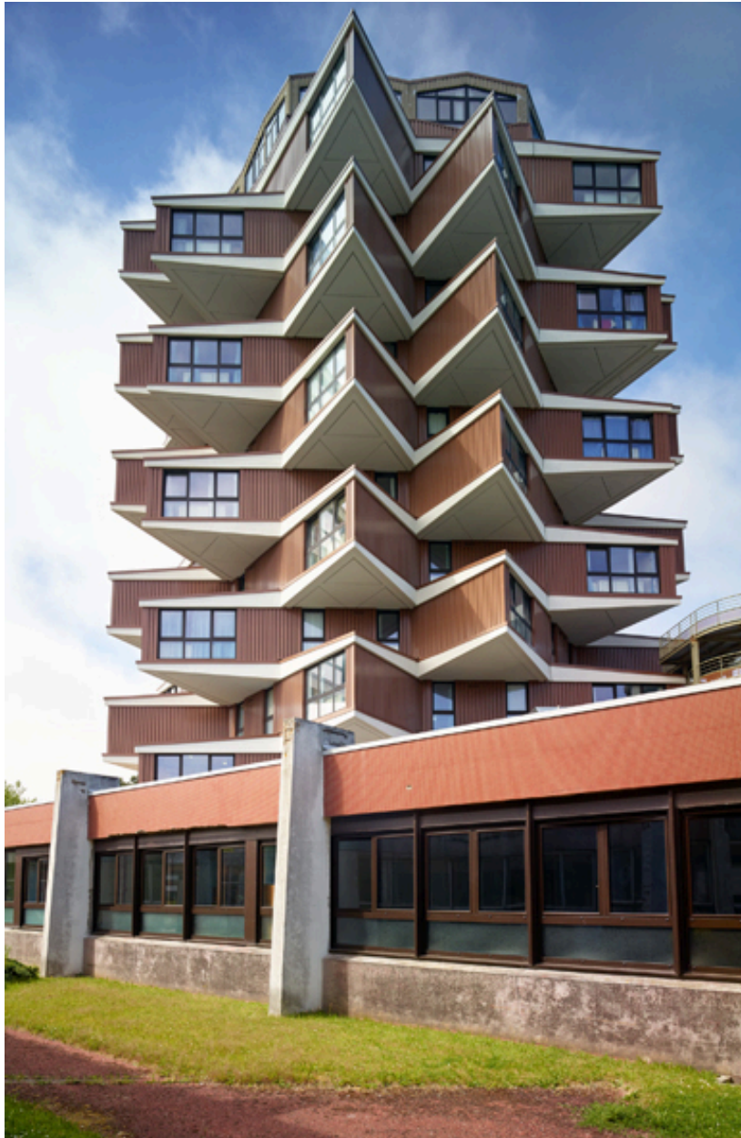
Élévation sud ouest de la tour de l'internat et élévation partielle du C.E.T., depuis le patio central.
