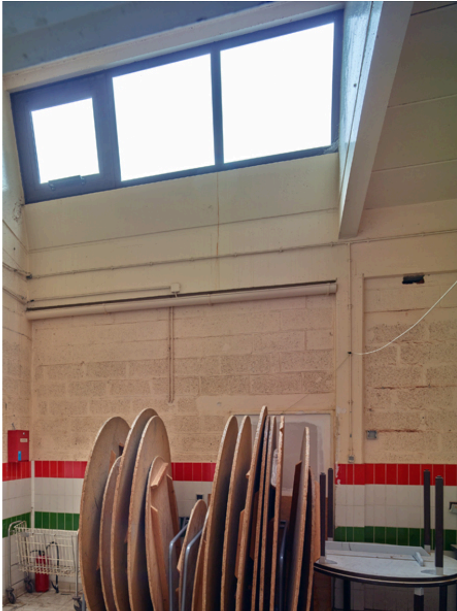
Vue des ouvertures dans la toiture à redents des anciennes cuisines pédagogiques.
