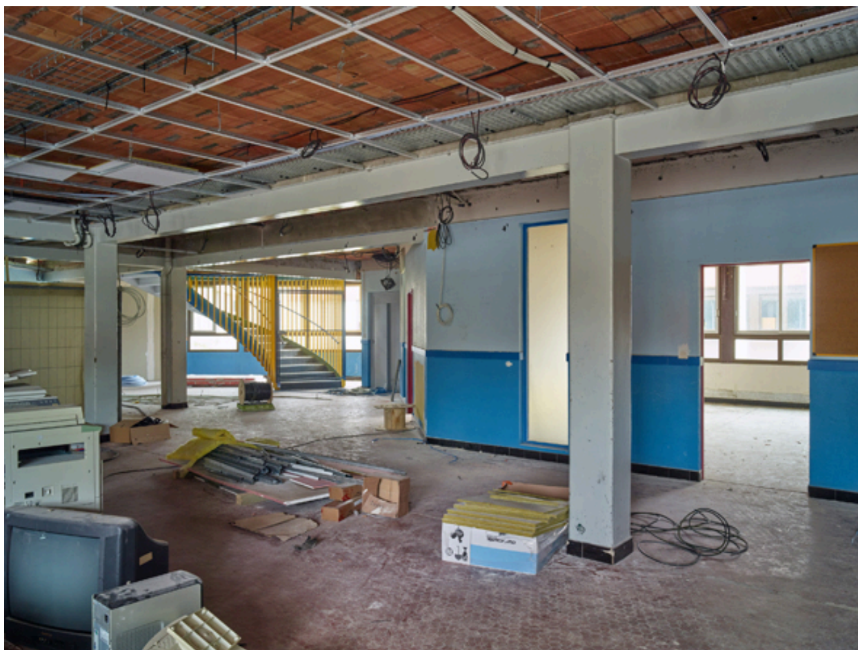
Vue générale de l'ancien préau couvert du C.E.S., situé au rez-de-chaussée.
