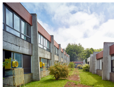
Vue générale du patio central sud ouest, depuis la liaison entre le C.E.S. et le C.E.T.
