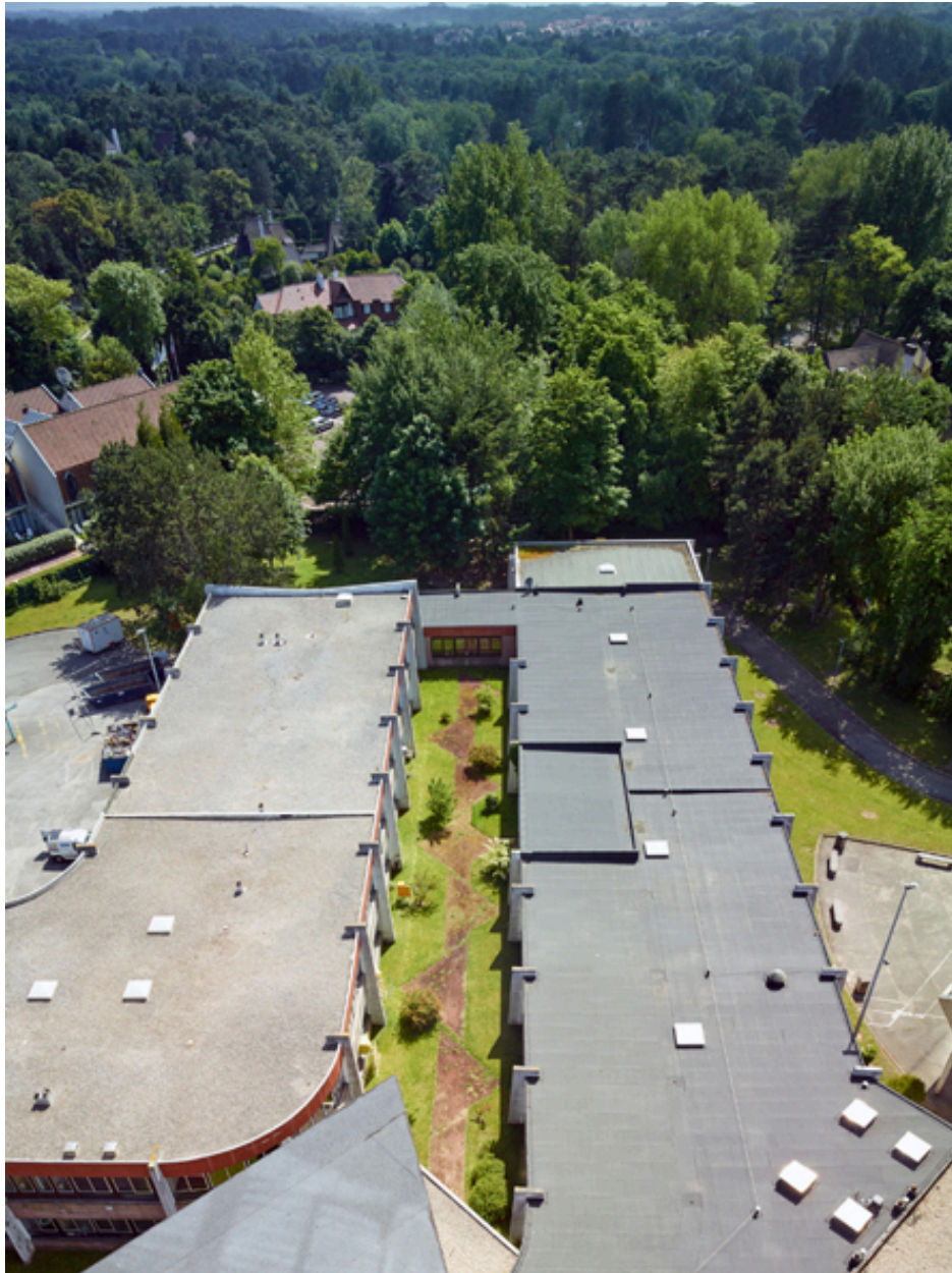
Vue générale du patio central sud ouest depuis la toiture de la tour de l'internat.
