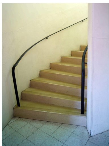
Vue du début d'une volée de l'escalier à double révolution de la tour de l'internat. Phot. Pierre Thibaut IVR32_20176200075NUCA
