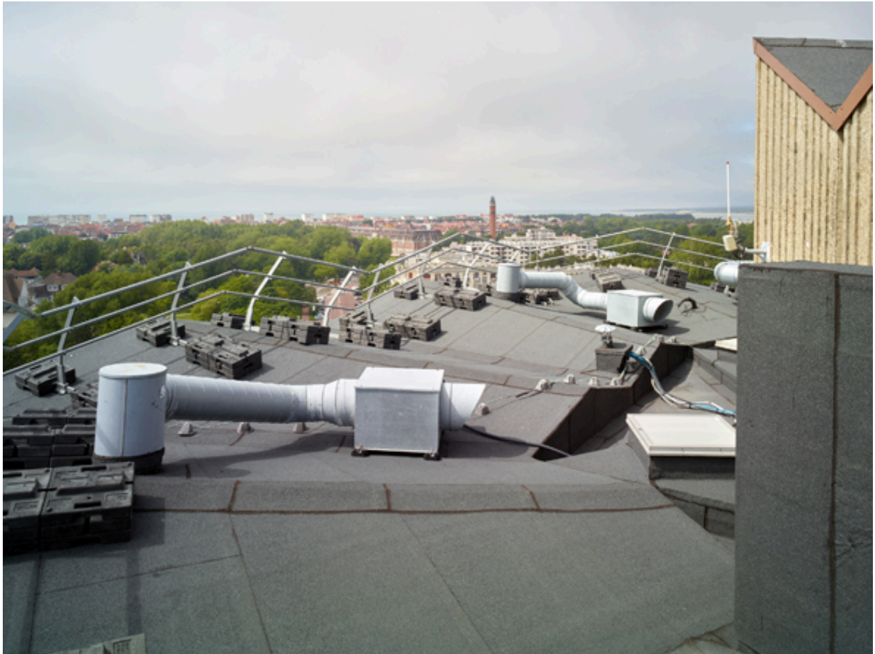
Vue de la toiture de la tour de l'internet.
