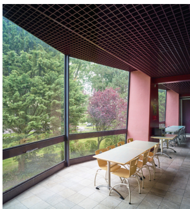
Vue partielle de l'avancée d'une baie de l'ancien restaurant d'application, côté nord est du bâtiment.
