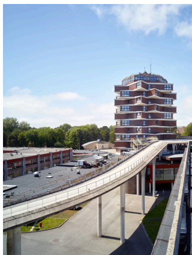
Vue générale de l'élévation est de la tour de l'internat, des toitures du C.E.T. et du C.E.S., et de la rampe d'accès menant à la plate-forme, depuis la toiture des logements de fonction.
