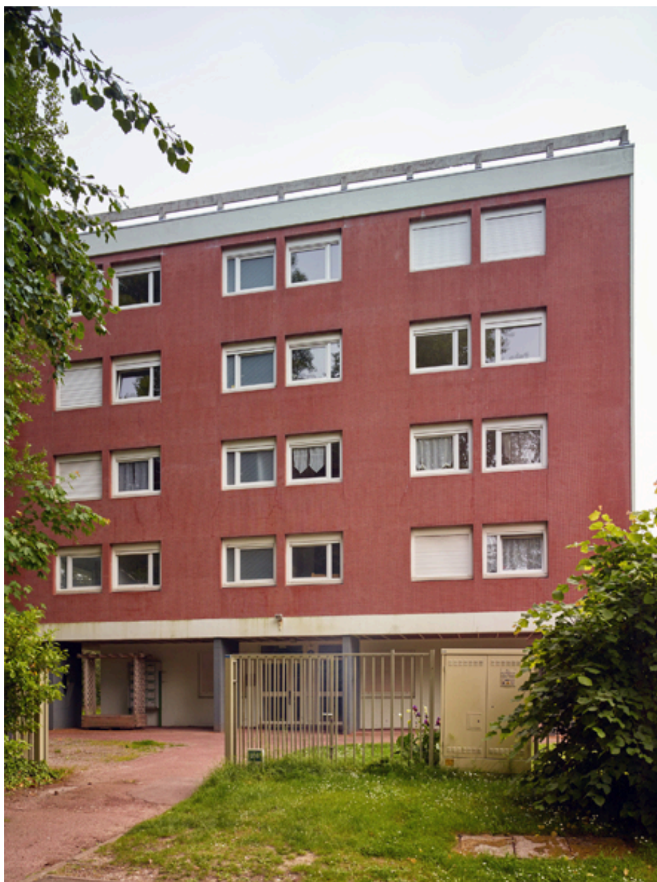
Élévation nord des logements de fonction.
