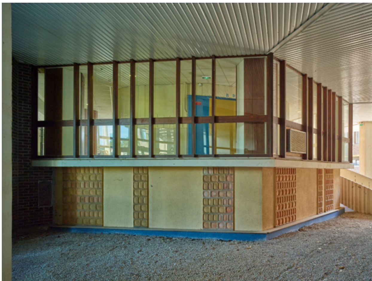
Vue extérieure du niveau de la plate-forme de la tour d'internat et des panneaux décoratifs de céramique, depuis l'ancien patio d'accueil.
