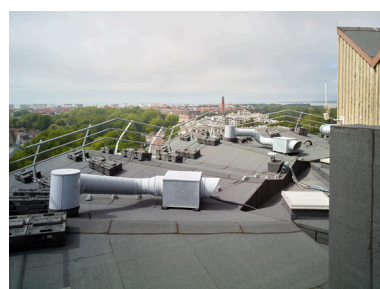
Vue de la toiture de la tour de l'internat. Phot. Pierre Thibaut IVR32_20176200095NUCA
