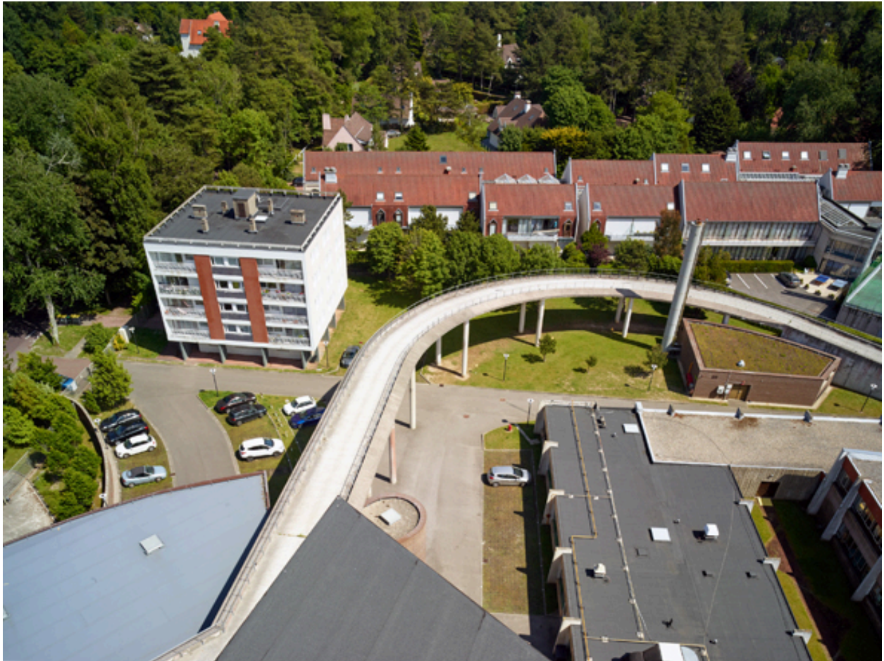
Vue générale de la rampe d'accès et des logements de fonction depuis la toiture de la tour de l'internat.
