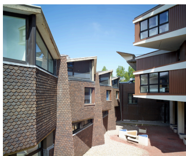
Vue de trois quarts de l'élévation sud des cuisines pédagogiques et son rapport avec les pointes de la tour de l'internat, au-dessus du patio d'accueil, depuis la toiture des locaux administratifs.
