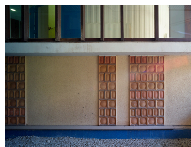
Vue rapprochée des panneaux décoratifs de céramique, situés à l'extérieur du rez-de-chaussée de la tour d'internat, depuis l'ancien patio d'accueil.
