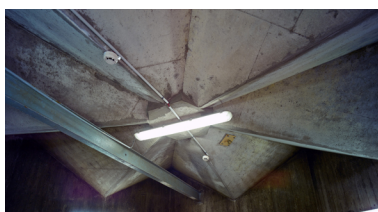
Vue de la sous-face de la toiture du local à machine de l'ascenseur de la tour de l'internat. Phot. Pierre Thibaut IVR32_20176200117NUCA
