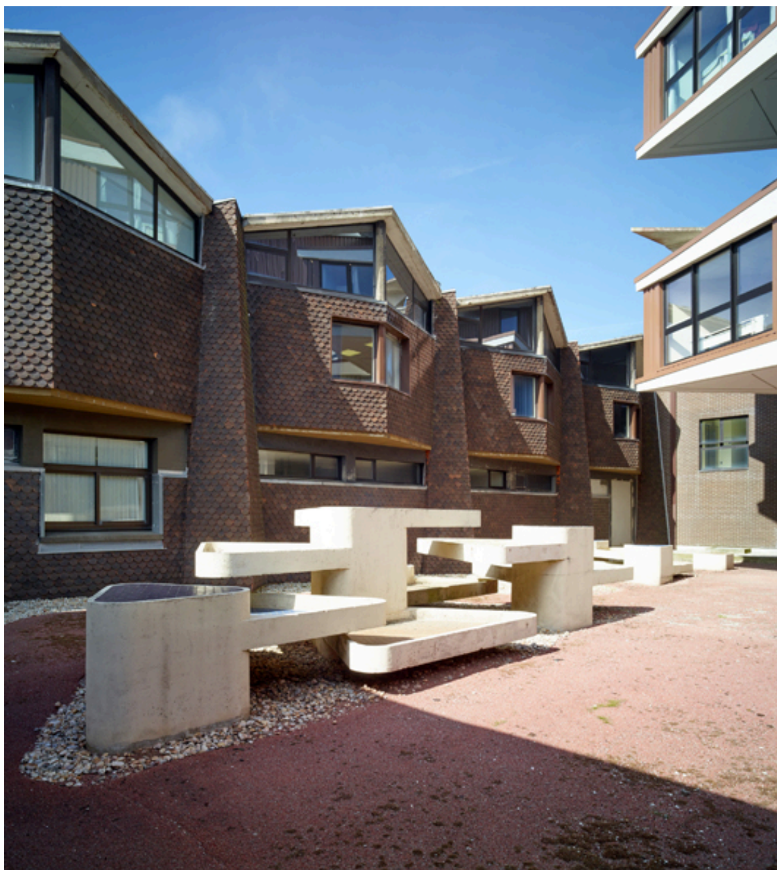
Vue de trois quarts de l'élévation sud des cuisines pédagogiques et des ensembles de sculptures-fontaines du groupe de l'Œuf, depuis l'ancien patio d'accueil.
