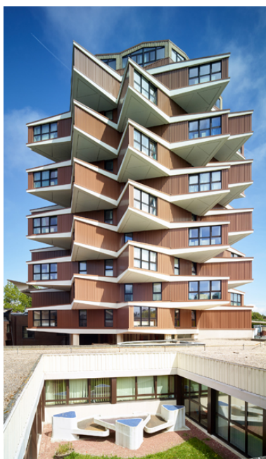
Vue de l'élévation ouest de la tour de l'internat et du patio de l'administration contenant un ensemble de sculptures-fontaines du groupe de l'Œuf, depuis la toiture des locaux administratifs. Phot. Pierre Thibaut IVR32_20176200113NUCA
