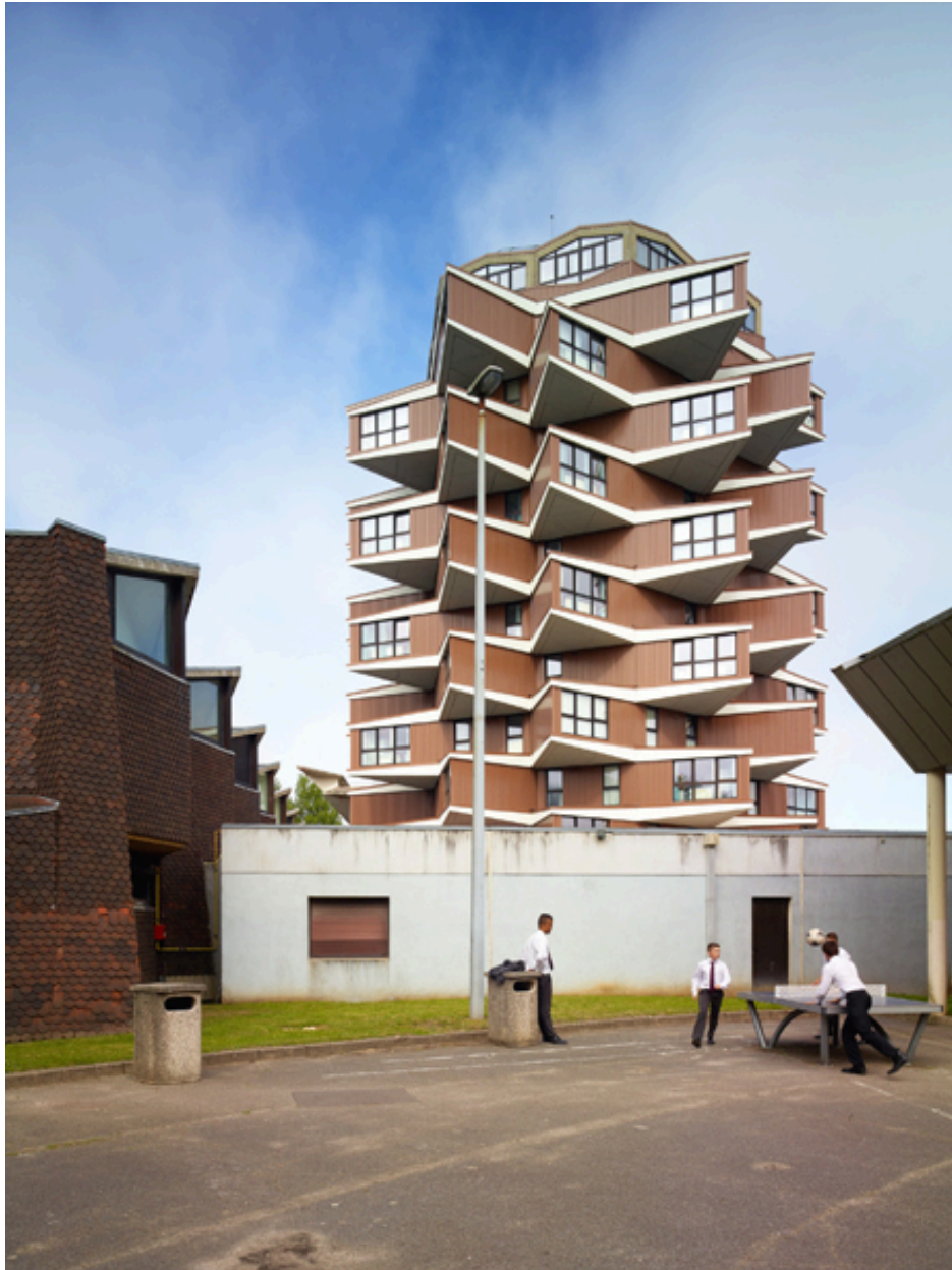
Vue de l'élévation ouest de la tour de l'internat et des locaux administratifs, depuis la cour du C.E.T.
