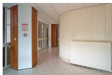
Vue des poteaux de forme hexagonale et du noyau central contenant les circulations de la tour de l'internat, depuis le niveau de la plate-forme. Phot. Pierre Thibaut IVR32_20176200133NUCA
