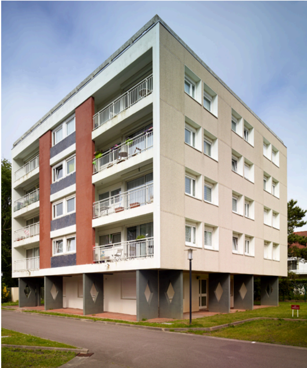
Vue générale de l'élévation ouest et sud (rénovation récente) des logements de fonction.
