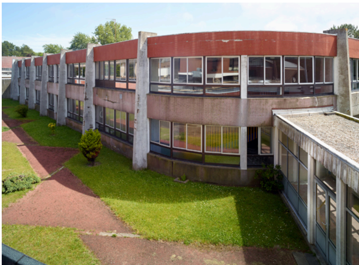
Vue de trois quarts de l'élévation sud du C.E.S., du patio central et de la liaison entre le C.E.S. et le C.E.T., depuis la toiture du C.E.T.
