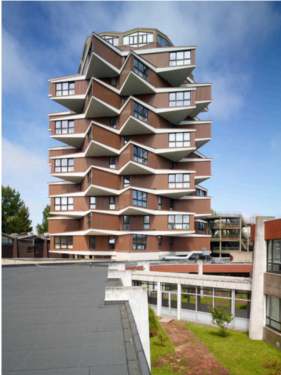
Vue de la liaison entre le C.E.S. et le C.E.T., depuis la toiture du C.E.T., vers l'élévation sud de la tour de l'internat.
