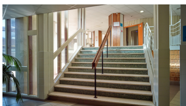
Vue générale de l'escalier menant au niveau de la plate-forme de la tour de l'internat, situé dans le hall d'accueil du bâtiment. Phot. Pierre Thibaut IVR32_20176200129NUCA
