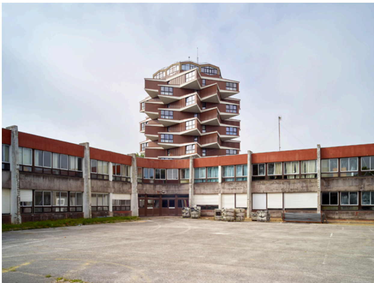
Vue des bâtiments du C.E.S. et de la tour de l'internat depuis la cour sud.
