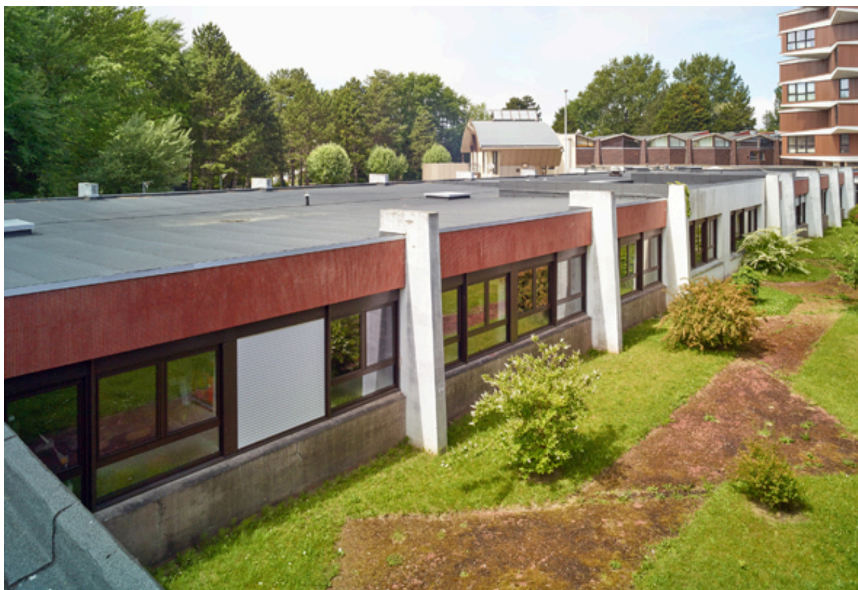
Vue de trois quarts de l'élévation est du C.E.T., depuis la toiture du C.E.T. fermant le patio.
