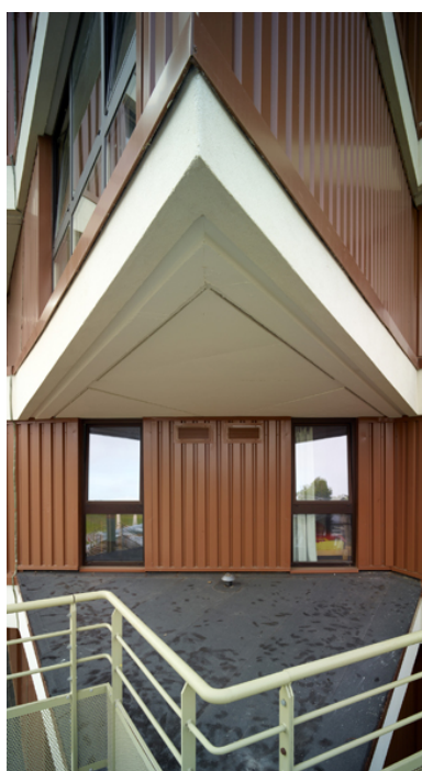
Vue rapprochée des modénatures en creux des sous-faces des pointes de la tour de l'internat, depuis l'escalier de secours de la rampe d'accès. Phot. Pierre Thibaut IVR32_20176200137NUCA
