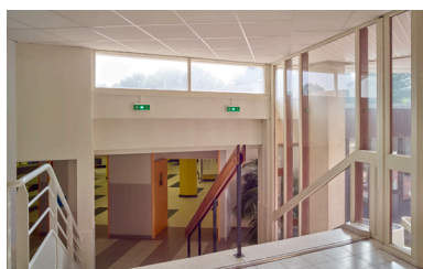
Vue depuis le niveau de la plate- forme de la tour de l'internat, vers l'escalier descendant dans le hall d'accueil du bâtiment. Phot. Pierre Thibaut IVR32_20176200134NUCA
