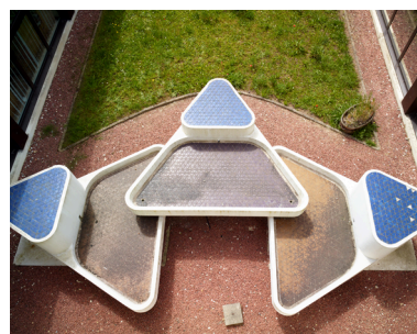
Vue de l'ensemble de sculptures-fontaines du groupe de l'Œuf, dans le patio administratif, depuis la toiture.
