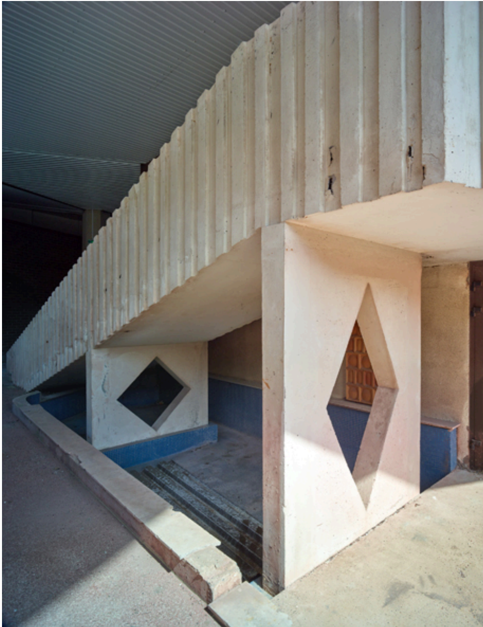
Vue des anciens bassins et des poteaux situés sous la sous-face de la rampe d'escalier extérieure menant au niveau de la plate-forme de la tour de l'internat, depuis l'ancien patio d'accueil.
