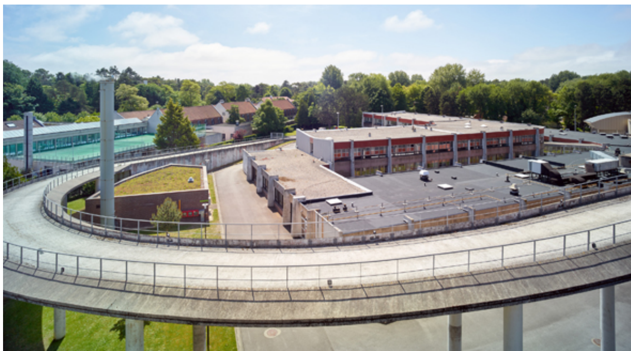
Vue générale des toitures du C.E.S., C.E.T., et de la rampe d'accès, depuis la toiture des logements de fonction.
