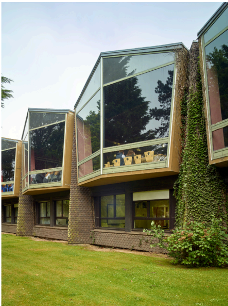
Vue de trois quarts, des éléments préfabriqués de forme pentagonale, entre les poteaux courants de l'élévation nord de l'ancien restaurant d'application.
