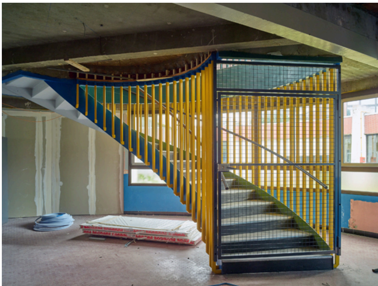
Vue de l'escalier situé dans le C.E.S., reliant le préau couvert du rez-de-chaussée, au hall de détente au premier étage.
