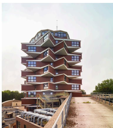
Vue de l'élévation est de la tour de l'internat depuis la rampe d'accès.
