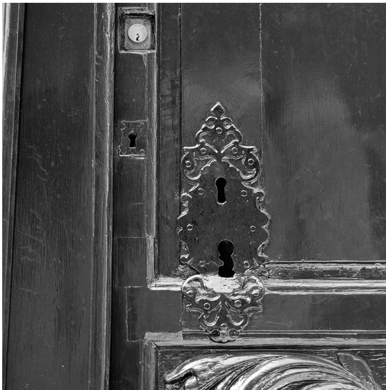
Porte cochère, entrée de serrure : détail.
