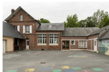
Cour et école de Viefvillers: ancien logement de l'instituteur, salle de classe et à droite, extension avec reprise de l'ancien préau. Phot. Marc Kérignard IVR32_20216000734NUCA
