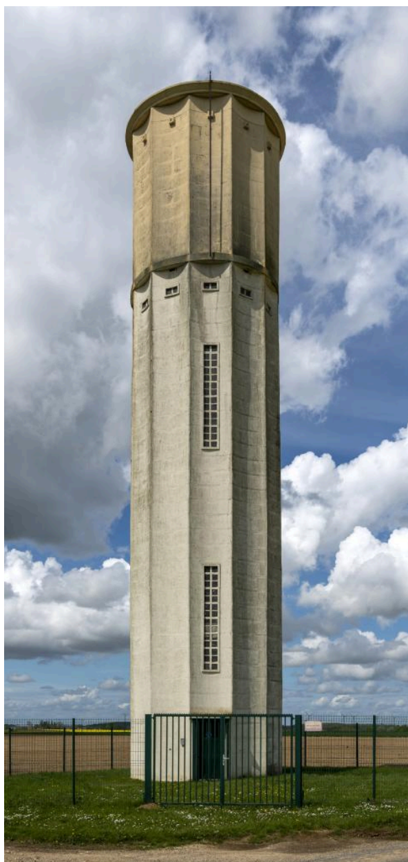
Vue générale du château d'eau de Viefvillers, à la sortie du village, route du Gallet.
