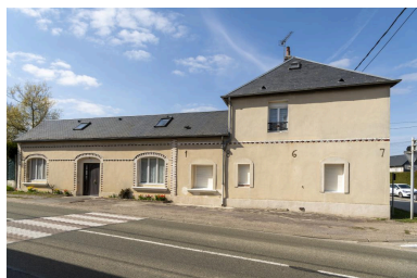
Ancien café, date portée: "1867", n °9 route de Rouen, vue depuis le sud. Phot. Marc Kérignard IVR32_20216000239NUCA
