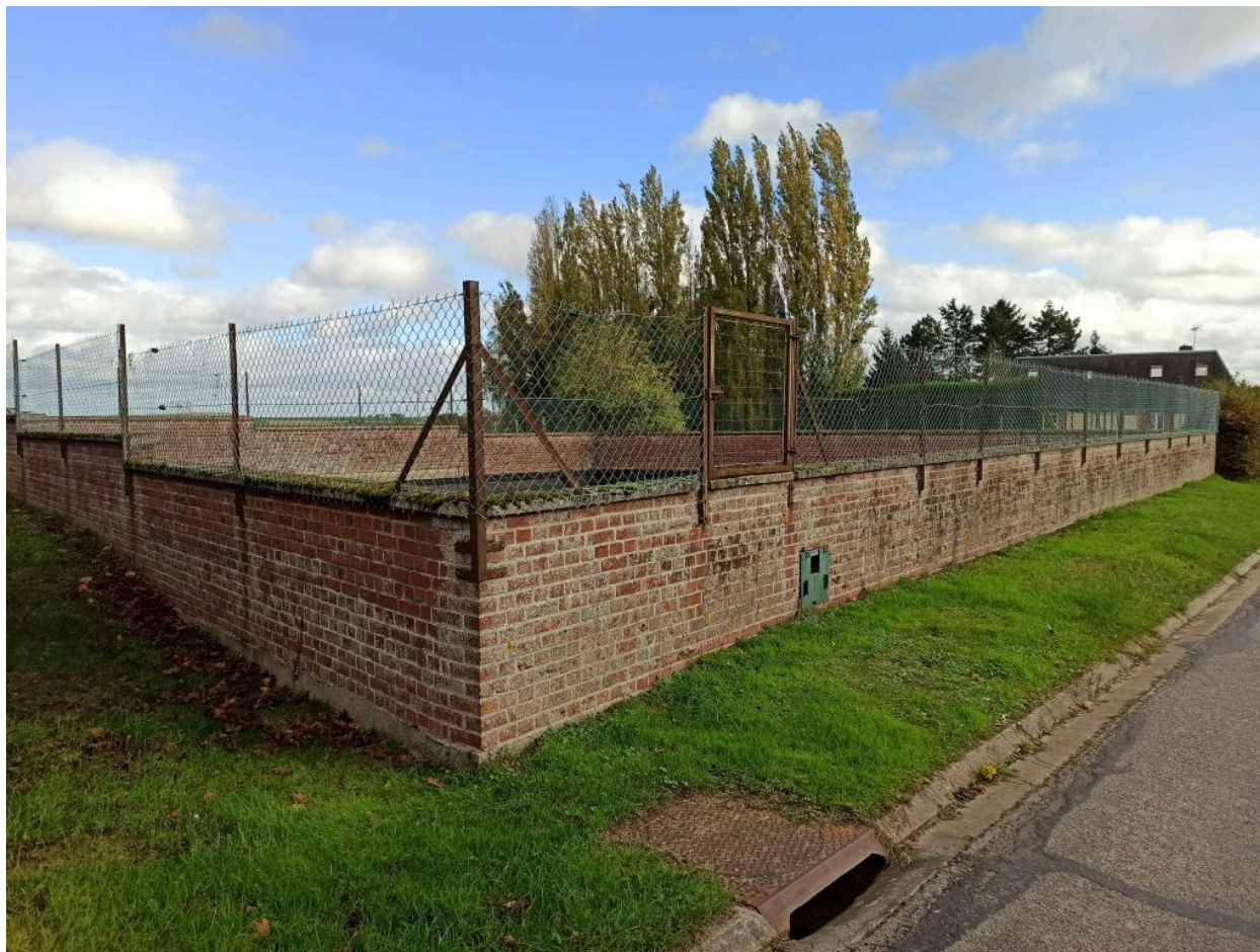
Mare avec murs maçonnés en brique, rue Principale, en face du n°27, vue générale depuis la rue.
