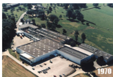
Vue des bâtiments de production, vers 1970. Phot. Frédéric-Nicolas Kocourek (reproduction) IVR22_20158005096NUCA
