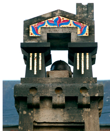
Détail. Phot. Thierry Lefébure IVR22_20038001121NUCA
