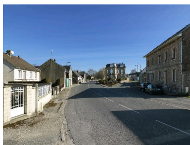
Vue vers l'est de la Grande rue. Phot. Thierry Lefébure IVR22_2015800092NUC2A
