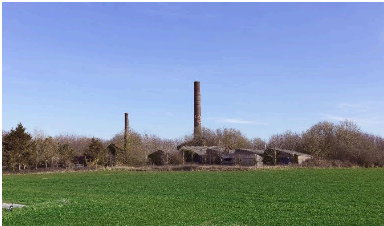
Ancienne briqueterie Flet.
