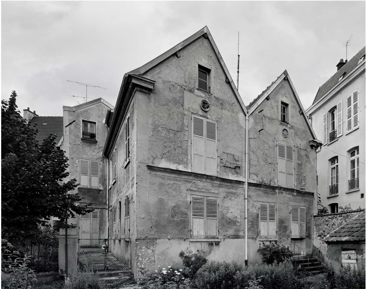
Vue des pignons sur le jardin.
