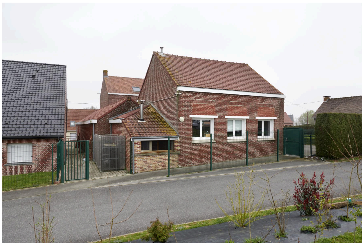
Arrière de l'ancienne salle de classe. Depuis l'ouest
