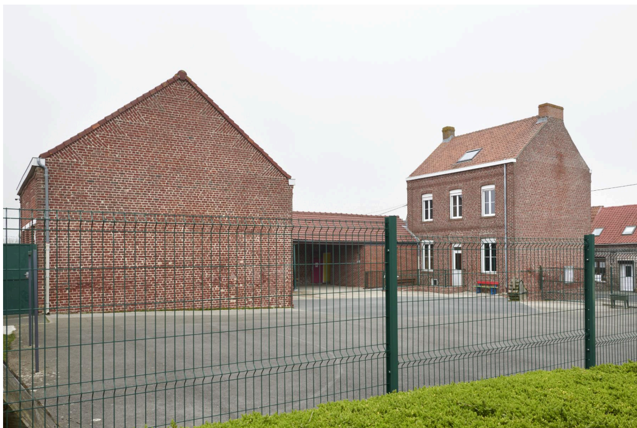
Arrière de l'ancien logement de l'institutrice et pignon sud de l'ancienne salle de classe.
