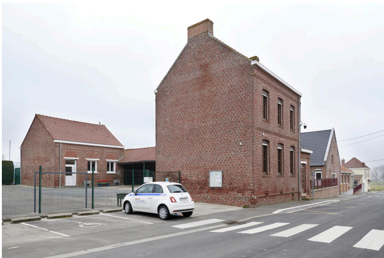
Vue générale. Façades et pignons sud, de l'ancien logement de l'institutrice (à droite) et de l'ancienne salle de classe (à gauche).
