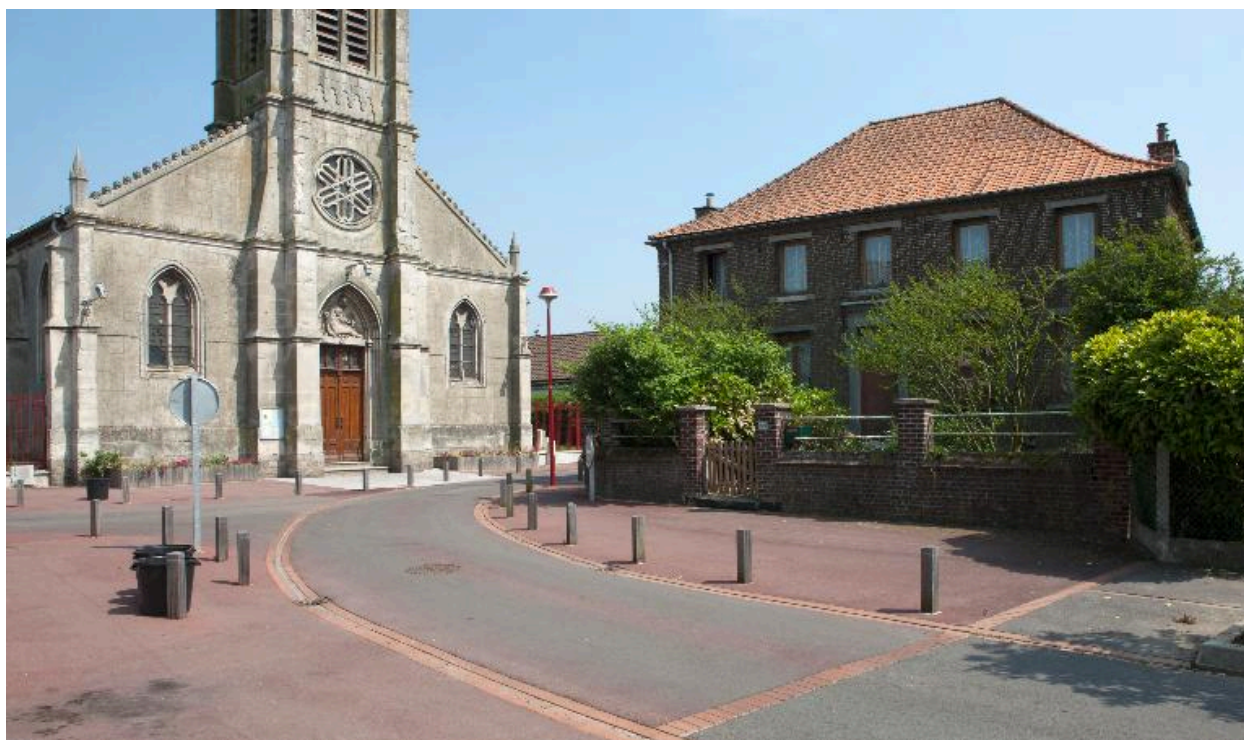
Vue générale de l'église.
