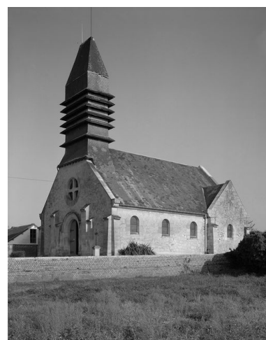
Vue générale. Phot. Jean-Michel Perrin IVR22_19846001311V
