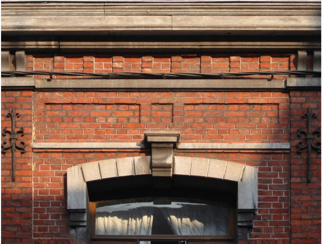
Détail : partie supérieure d'une travée, reliefs de briques, emploi de la pierre et ancrages de fonte.
