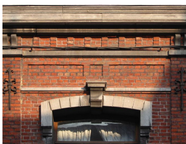
Détail : partie supérieure d'une travée, reliefs de briques, emploi de la pierre et ancrages de fonte. Phot. François Bisman IVR31_20065906185NUCA
