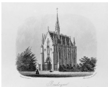
Vue d'angle sud-ouest vers 1890, guide Merridew. A.P. Phot. Jean-Michel Périn IVR31_19866200545X
