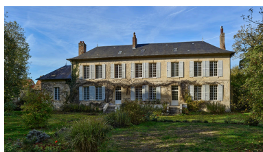
Vue générale de l'ouest de la maison de maître. Phot. Thierry Lefébure IVR32_20220200261NUCA
