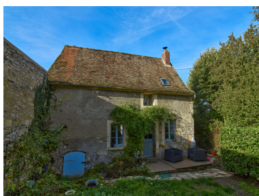
Vue de l'est de la façade sur jardin de la maison de vigneron. Phot. Thierry Lefébure IVR32_20220200264NUCA
