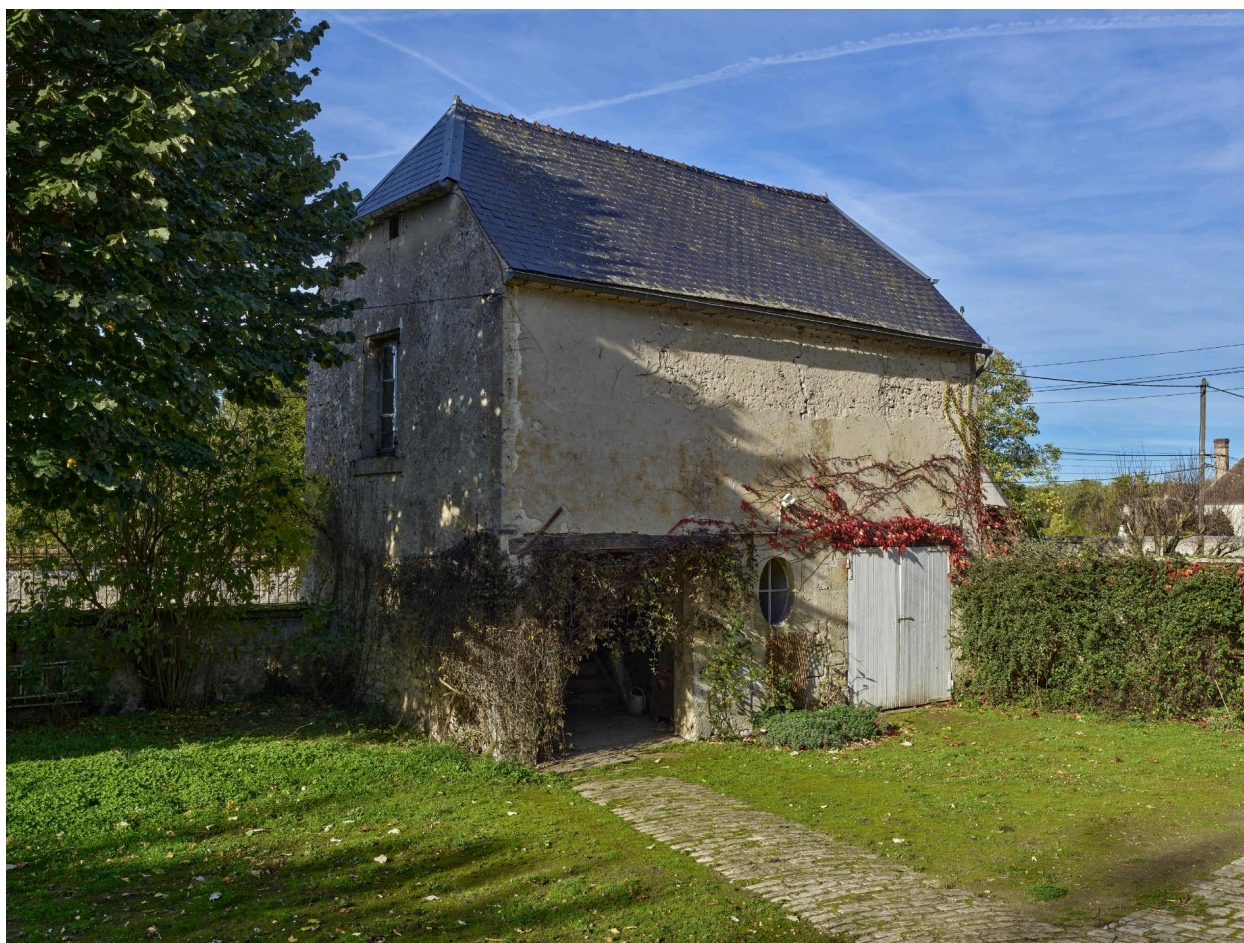
Vue du sud-est de la remise.
