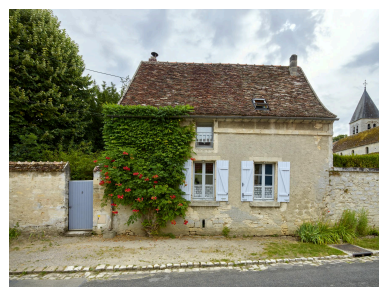
Vue de l'ouest de la façade sur rue de la maison de vigneron. Phot. Thierry Lefébure IVR32_20230200275NUCA
