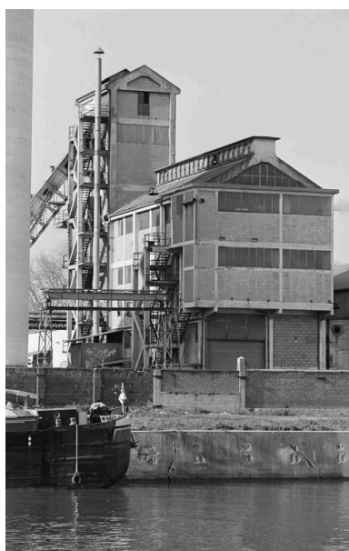
Atelier de fabrication : flanc est. Phot. Benoît Dufournier IVR22_19936002425Z
