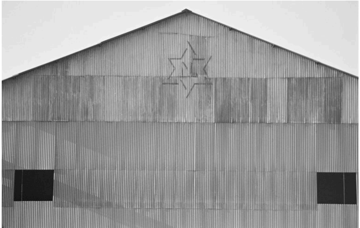
Magasin industriel : flanc est.
