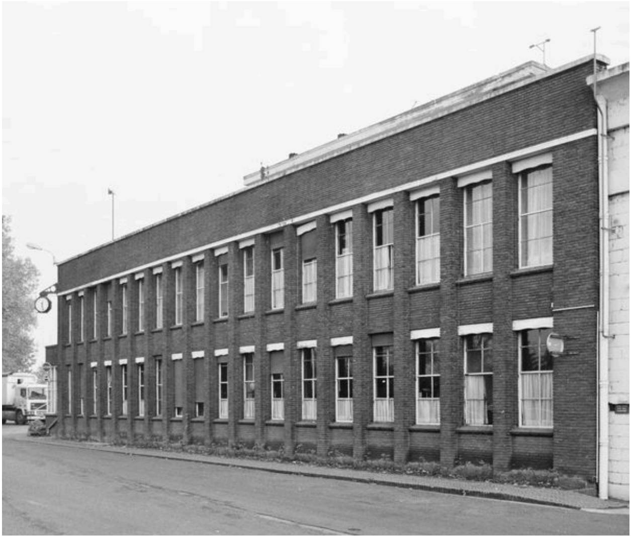
Bureau : élévation antérieure.
