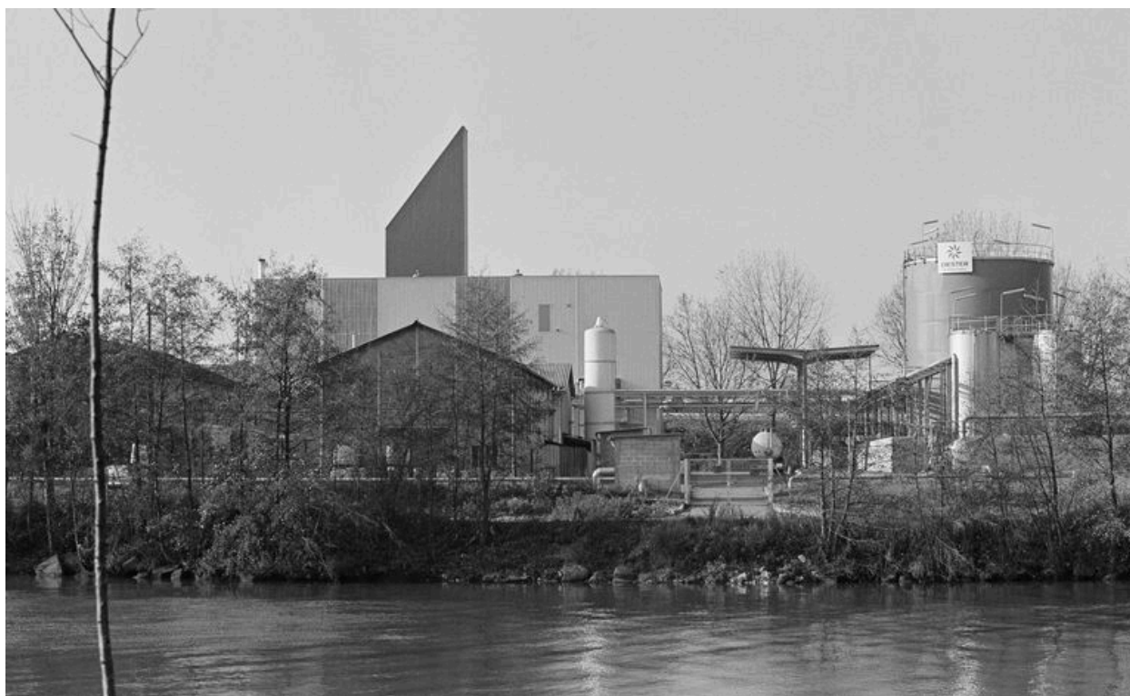
Vue partielle de l'atelier de fabrication de diester, flanc est.
