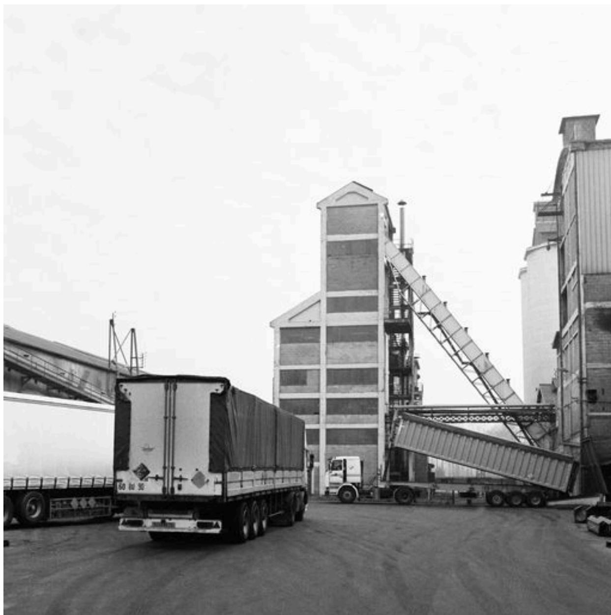
Atelier de fabrication : flanc ouest.
