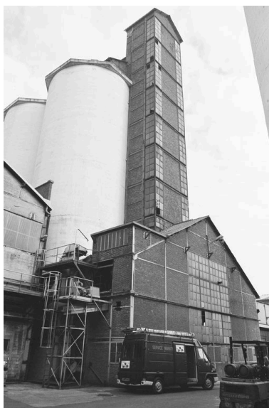
Réservoir industriel : vue partielle. Phot. Benoît Dufournier IVR22_19936002367Z
