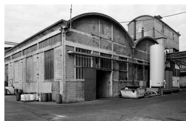
Entrepôt industriel. Phot. Benoît Dufournier IVR22_19936002365Z
