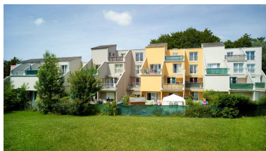
Vue de l'extrémité est de l'îlot : un talus planté isole les terrasses et les jardins de l'avenue Champollion. Les décrochements et murs de refend(?) assurent latéralement une meilleure intimité aux espaces extérieurs. Phot. Pierre Thibaut IVR32_20185900680NUCA
