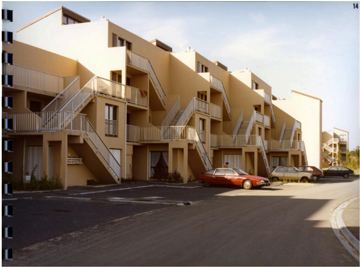
Vue de 1978 depuis la rue des Chercheurs (AC Villeneuve d'Ascq ; 16W3)
