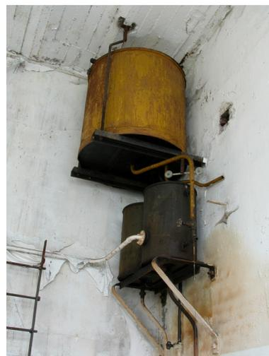
Bacs d'eau pour le refroidissement des cylindres de la machine.
