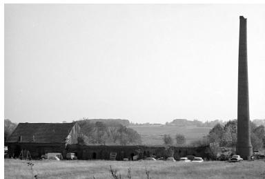
Cheminée d'usine, vue générale.
