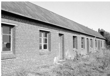
Logement d'ouvriers, vue générale, élévation antérieure.
