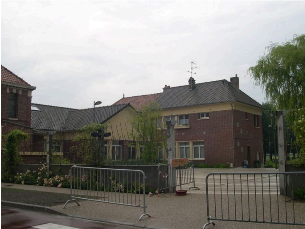
Détail sur l'extension nord-est.
