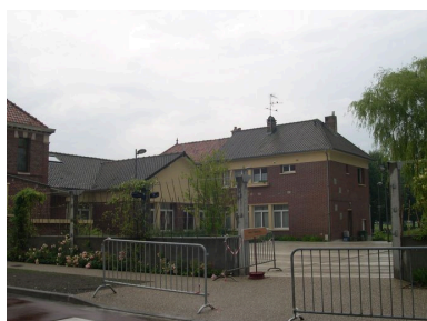
Détail sur l'extension nord-est. Phot. Isabelle Barbedor IVR22_20038010614NUCA
